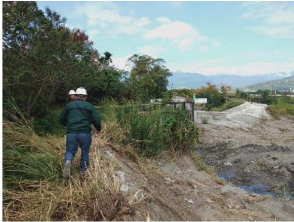
說明：工地現況
