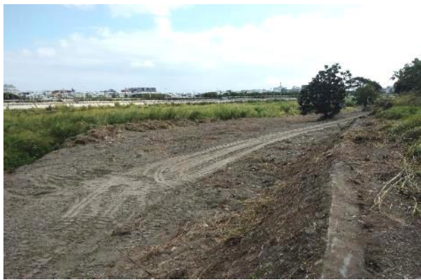
說明：工地現況
