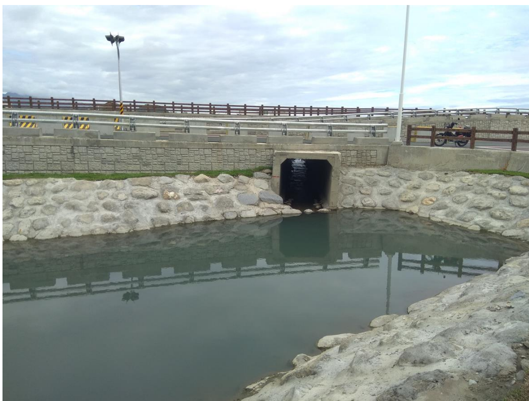
說明：卑右三生態池連通太平溪箱涵狀況
