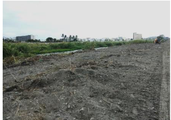
說明：工地現況
