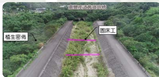
混凝土堤防太過生硬(嘉豐溪)
