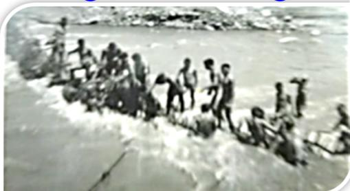
缺乏推土機及怪手的時代，關山大圳入水頭(口)，夏季因洪水破壞，用人工「作埤頭」引水入關山大圳，供農田灌溉。
