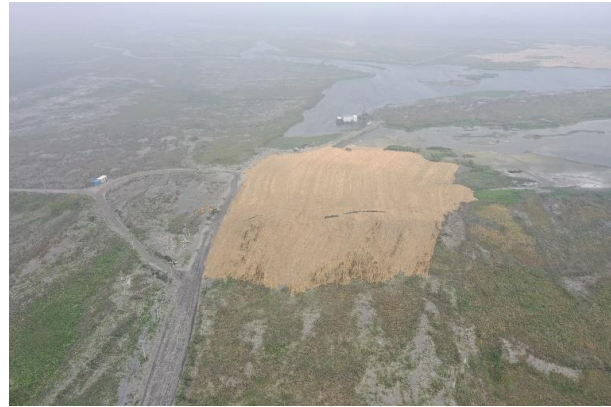
200公頃稻草蓆鋪設
