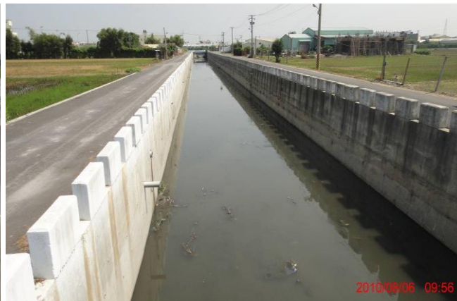
麻剪溝排水改善工程 (二工區)
