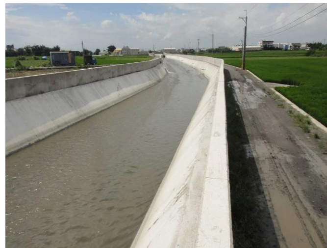
安東二排改善工程
