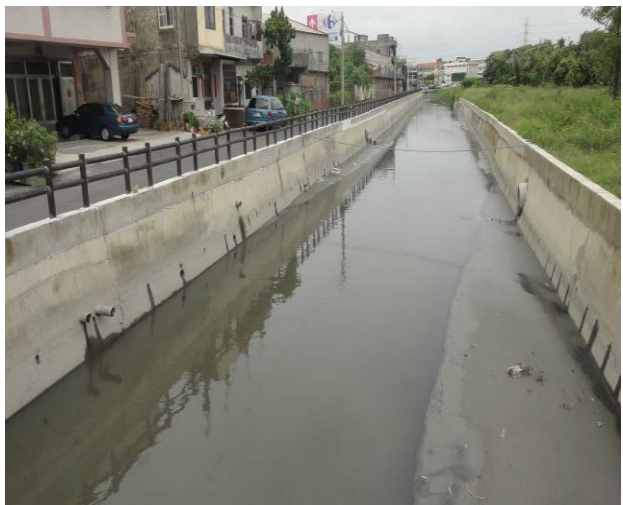
花壇排水改善工程
