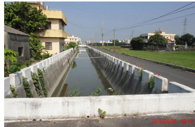
麻剪溝排水改善工程 (三工區)
