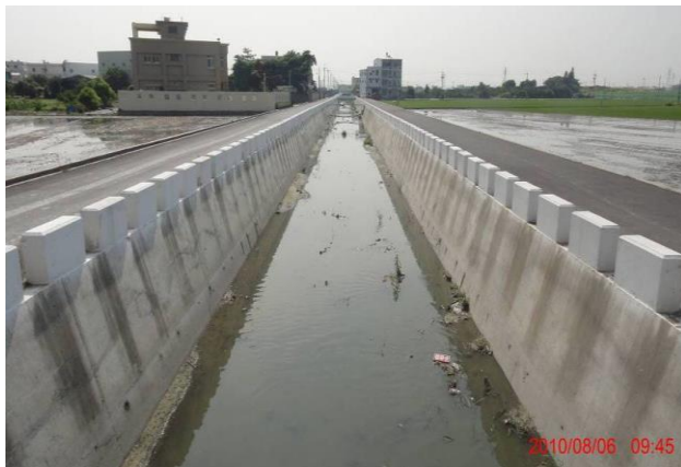
麻剪溝排水改善工程 (一工區)
