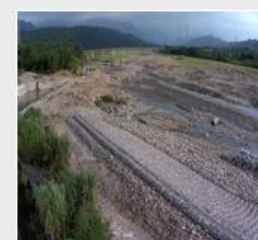
桶頭防災減災工程
