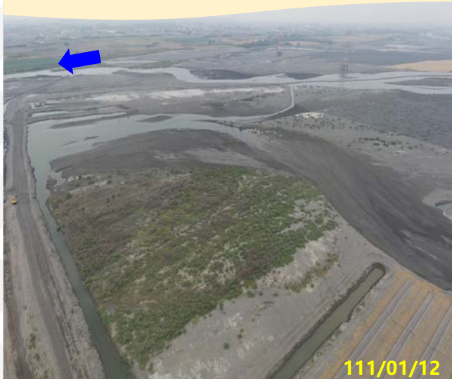
跨河鐵塔下游
