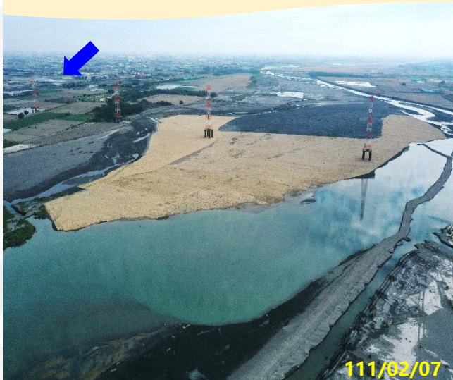
跨河鐵塔下游
