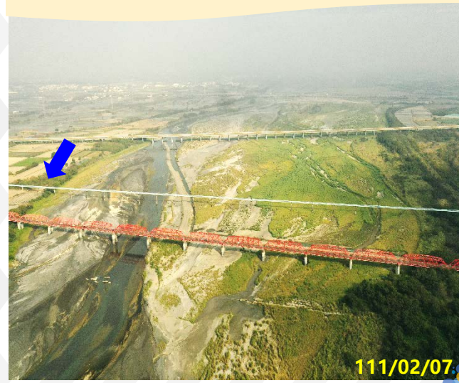
第五區溪州大橋下游
