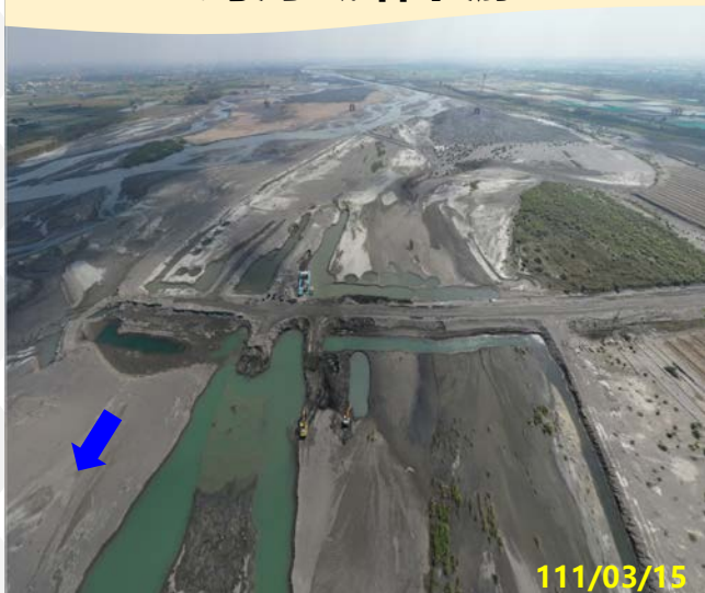
跨河鐵塔下游
