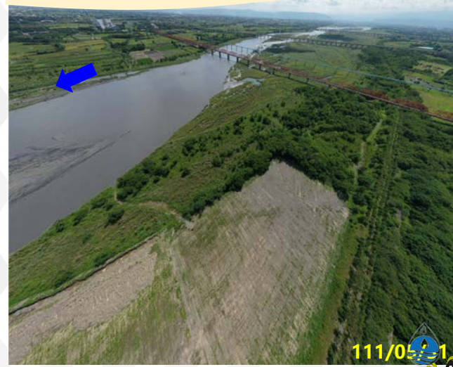
第五區 西螺大橋上下游
