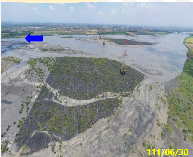
跨河電塔上下游
