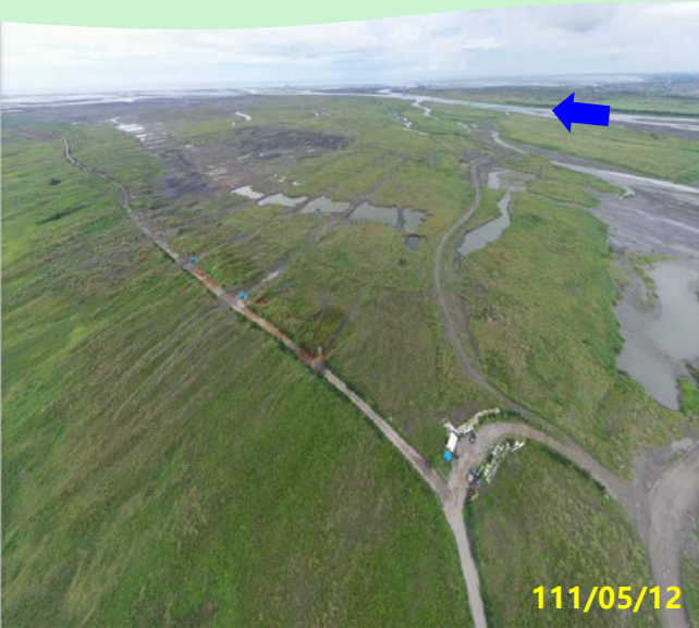
第一區 出海口 0號井
