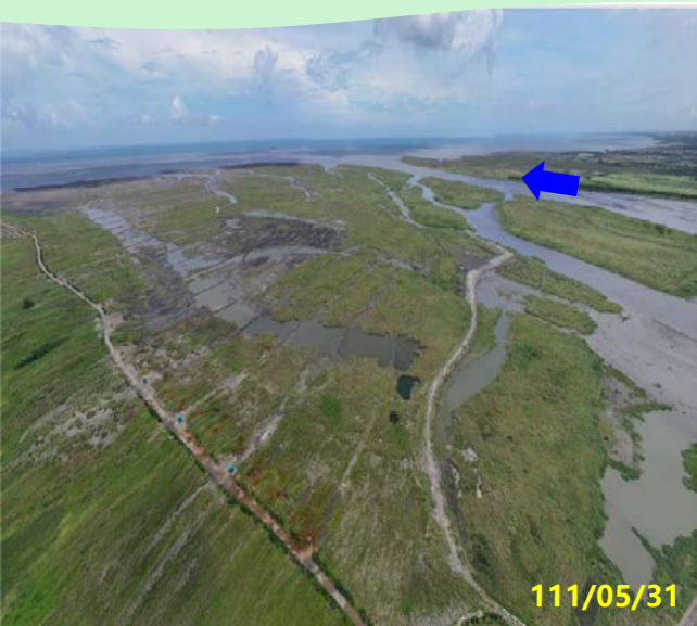
第一區 麥寮出海口 0號井
