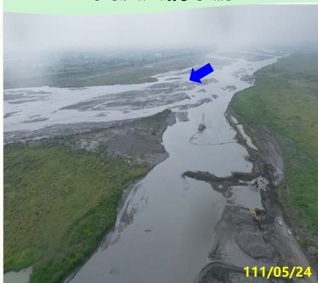
第一區 西濱大橋下游
