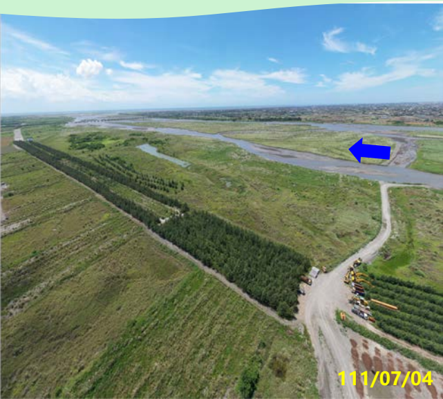
第二區 大庄堤防(40號越堤路)下游
