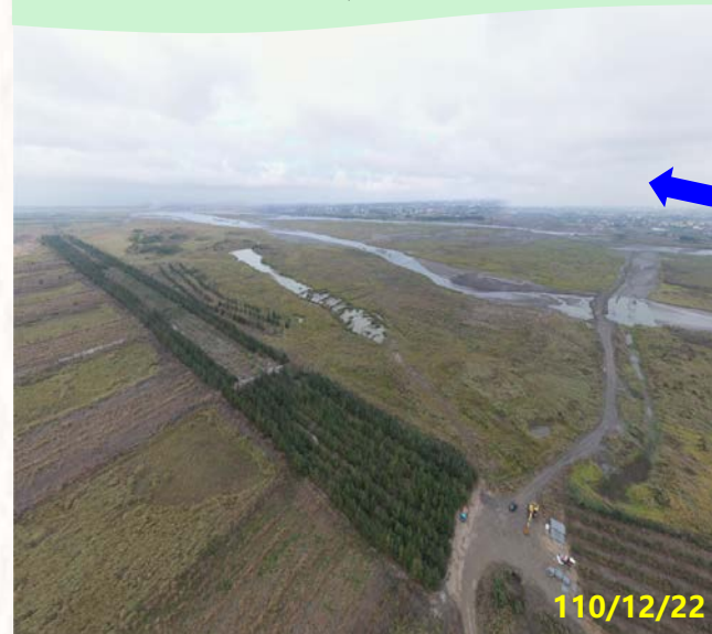
第二區 大義崙下游40號越堤
