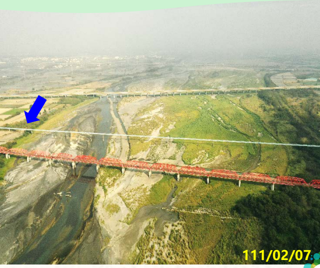
第五區溪州大橋下游
