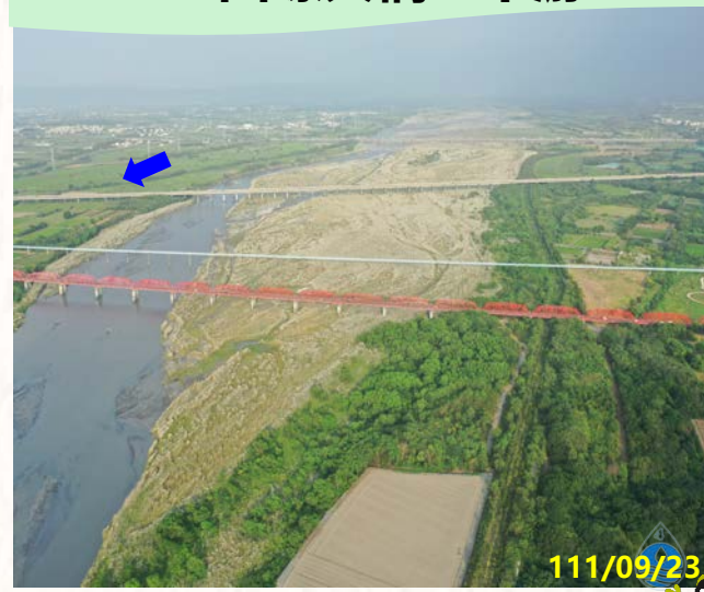
第五區 西螺大橋上下游
