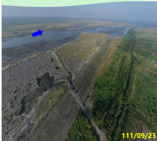
第一區 下海墘堤防(7號越堤路)上下游
