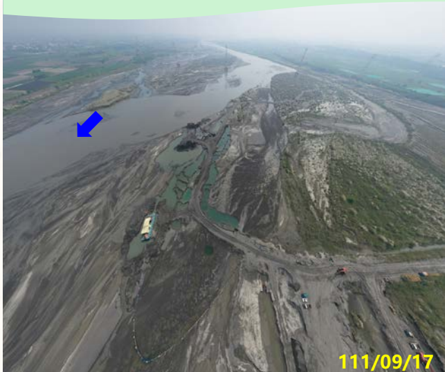
楊賢堤防(74號越堤路)上游
