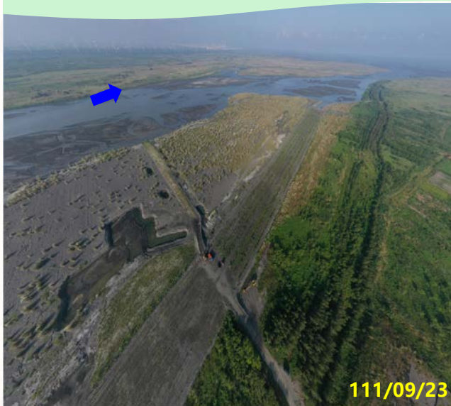
第一區 下海墘堤防(74號越堤路)上下游
