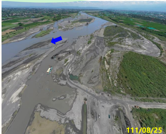
楊賢堤防(74號越堤路)上下游
