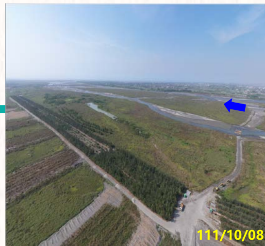
第二區 大庄堤防(40號越堤路)下游
