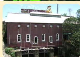
縣定古蹟-林內濁水發電所
