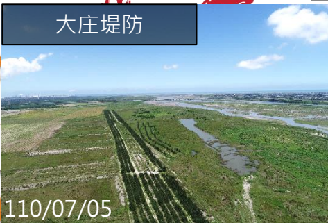
大庄堤防延伸段
