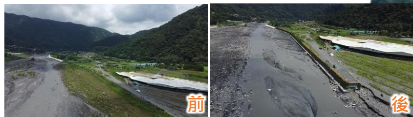
卡努颱風後新武界橋下游左岸高灘地流失
