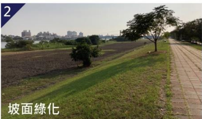
目前堤防坡面部分為混凝土型式，建議培厚綠化，增加綠覆率。
