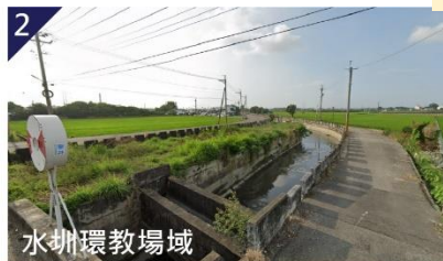
水圳環教場域 永基二圳為百年水圳,為當地重要灌溉設施,建議可以設置解說設施,作為水圳文化的傳承。
