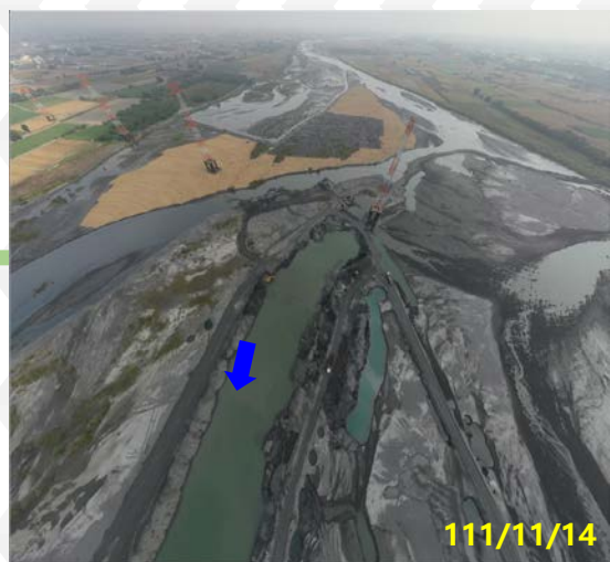
第三區 跨河電塔下游
