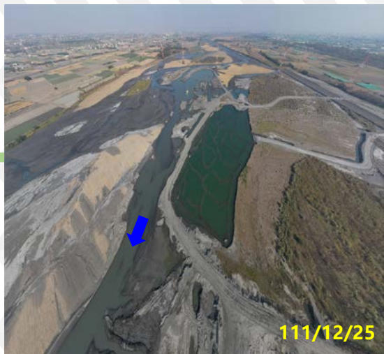
第三區 楊賢堤防(74號越堤段)上下游
