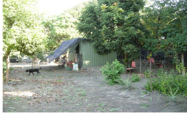
110 年 12 月 06 日高屏溪崇蘭段 R319 號查獲楊○嘉君未許可於河川區域內搭建鐵皮工寮
