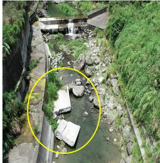
戽台側邊混凝土斷裂(照片來源：九河局)
