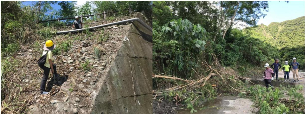
圖 5-10 銀合歡主要生長在漿砌護岸破損處或石籠擋土牆上
