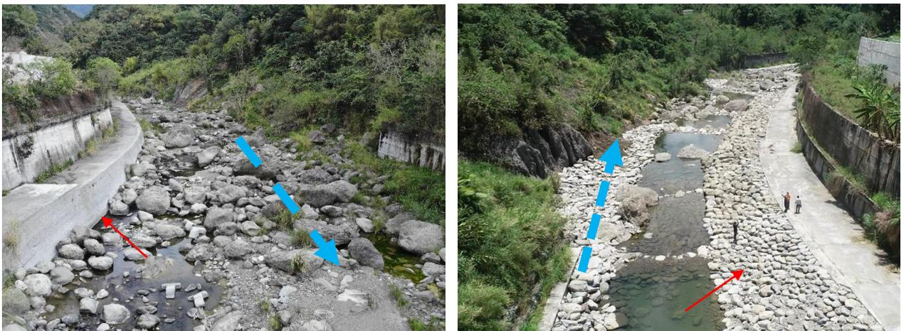
圖 7-14 圖左：施工前右岸戽台底部落差大 / 圖右：完工後右岸因拋填塊石落差降低（藍色為水流方向）
