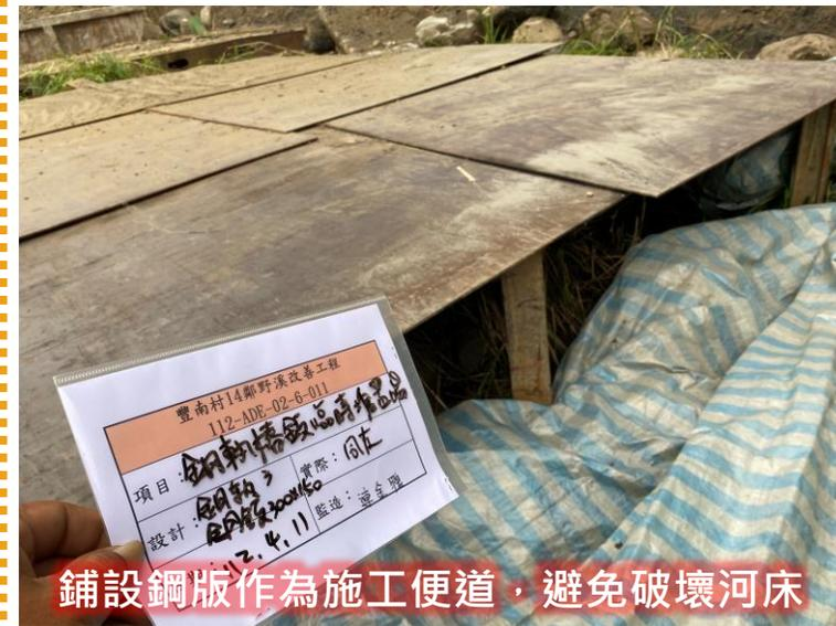
鋪設鋼版作為施工便道，避免破壞河床
