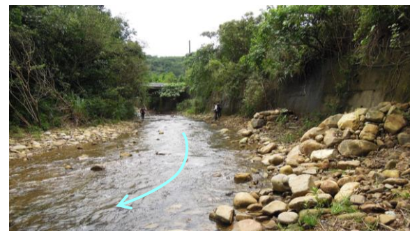
田寮洋一、二、三圳取水設施改善工程
