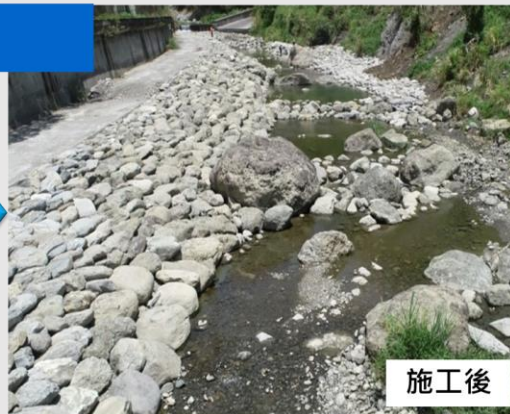
河岸粗糙化-改善平滑護岸
