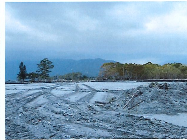
③土砂暫置區現況
