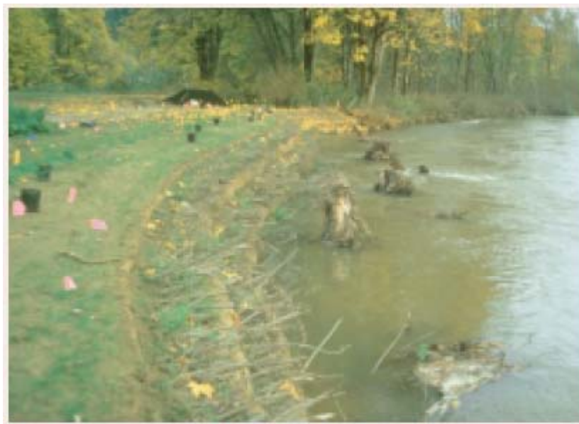
圖 4.18 護岸植生工法-施工完成後 (FISRWG, 2001)
