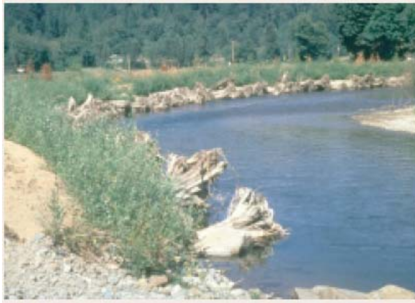
圖 4.19 護岸植生工法-施工完成一年後 (FISRWG, 2001)
