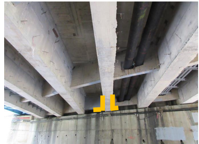
武嶺橋梁底現況
