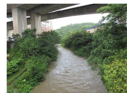
4. 民樂橋上游天然土渠現況
