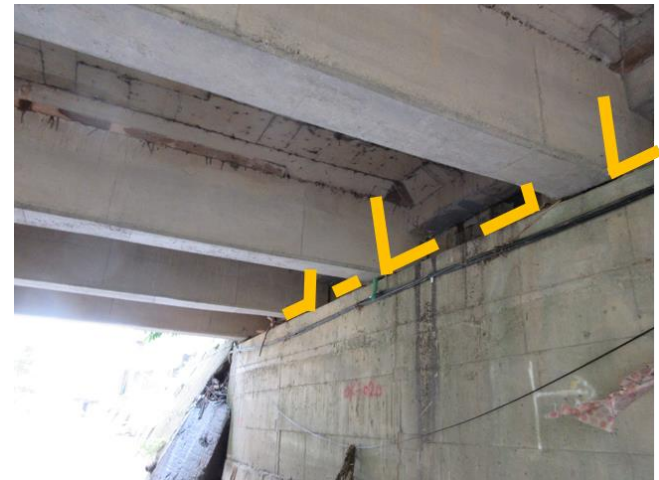
安樂五橋梁底現況
