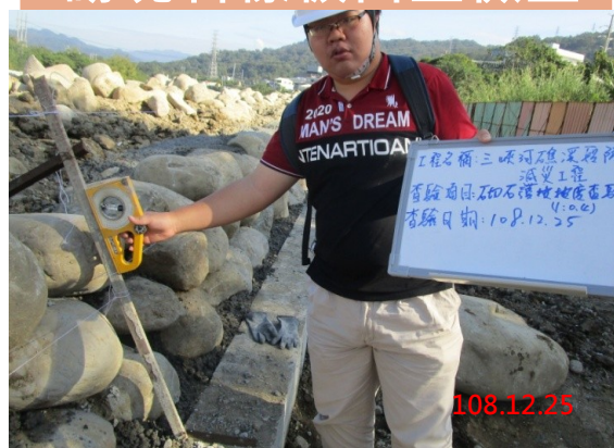
砌塊石完成自主檢查
