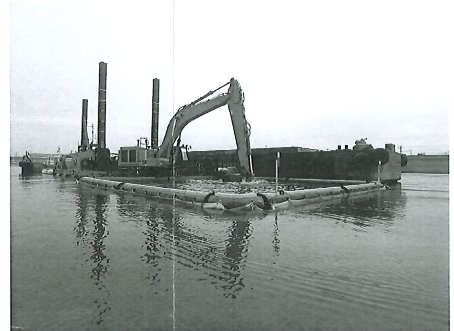
污濁防止膜設置示意照片
