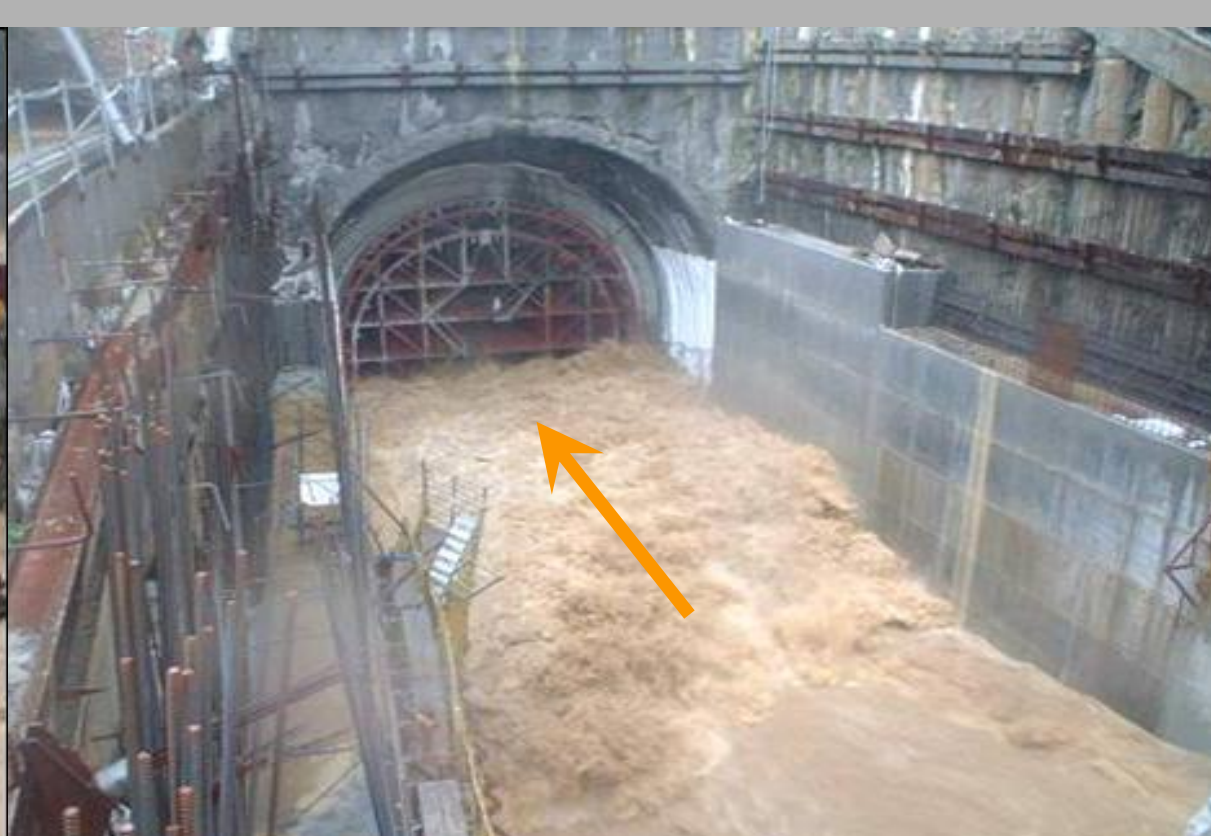
緊急分洪隧道入口流況
