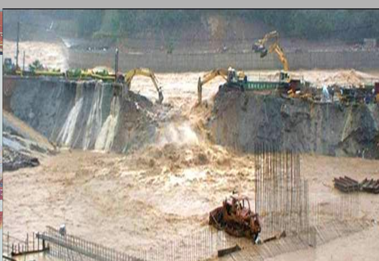
挖除施工便道緊急分洪
