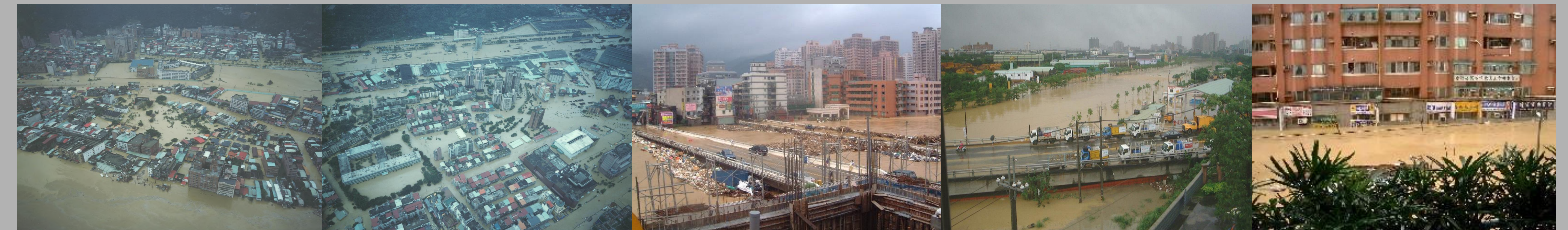
汐止市淹水航拍圖 汐止市淹水航拍圖 汐止市 汐止市 汐止市
