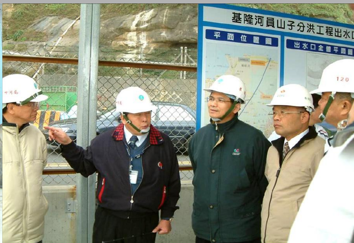
前行政院游院長視察工地
