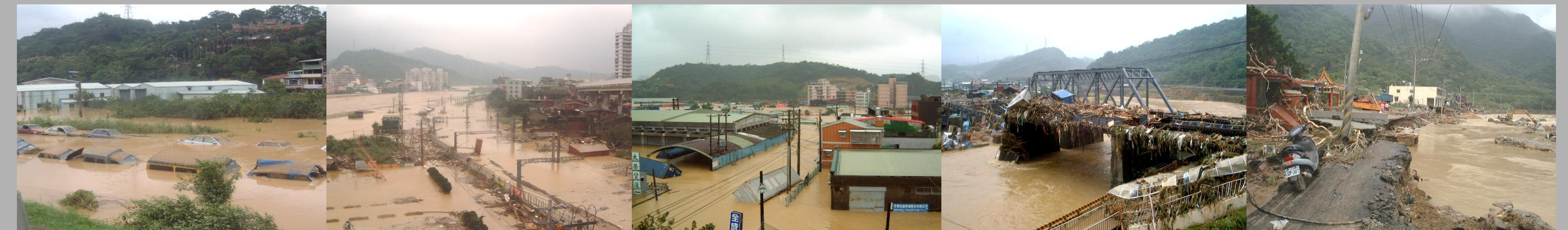
汐止市 五堵火車站附近 七堵大榮貨運附近 八堵鐵路6號橋沖毀 瑞柑新村道路沖毀
