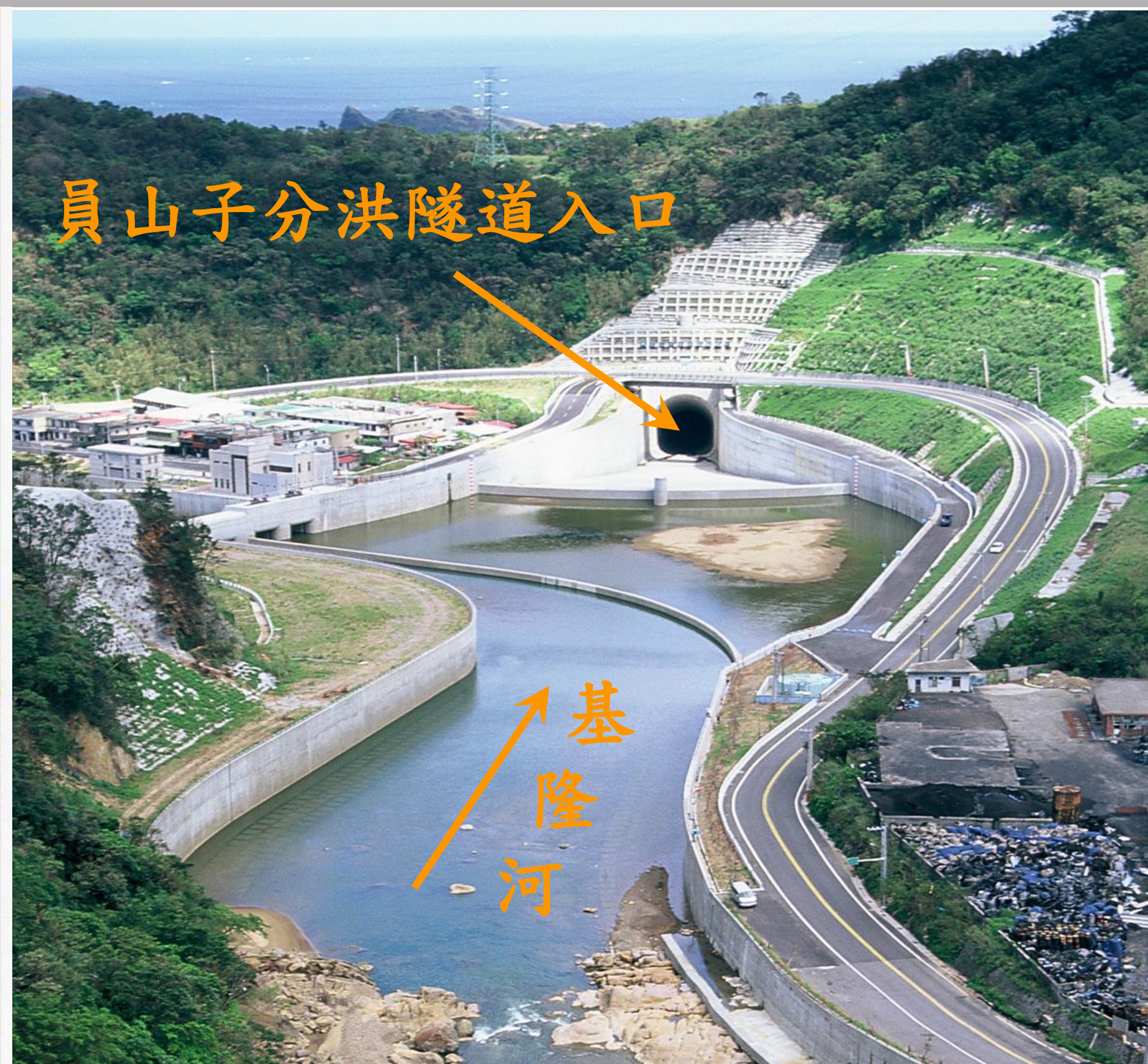
員山子分洪入口全景
