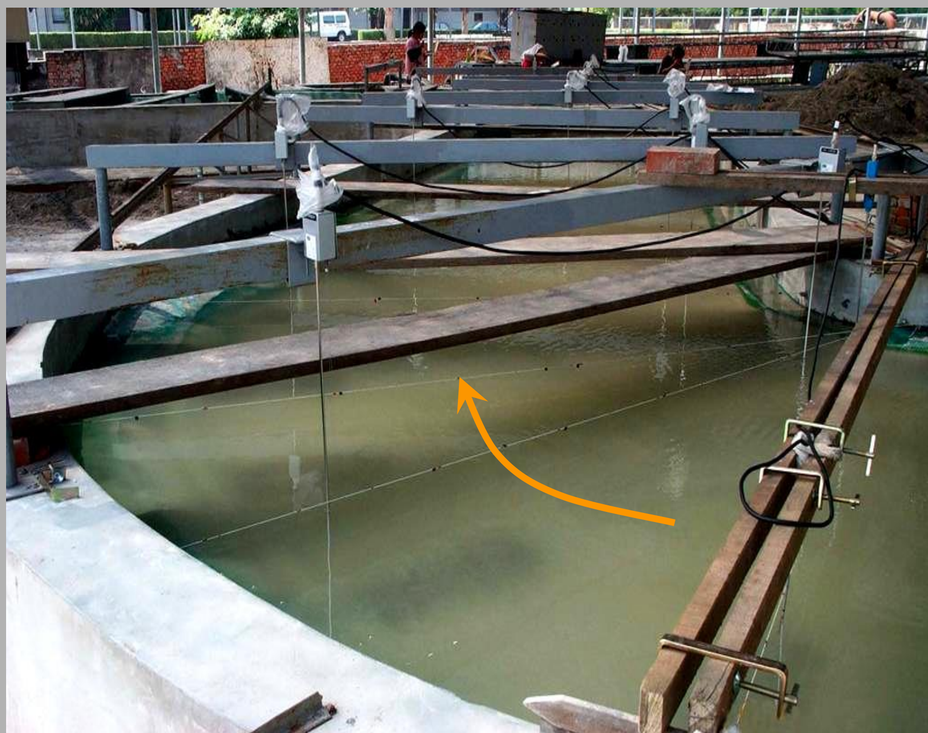
水位計及流速儀架設情形
