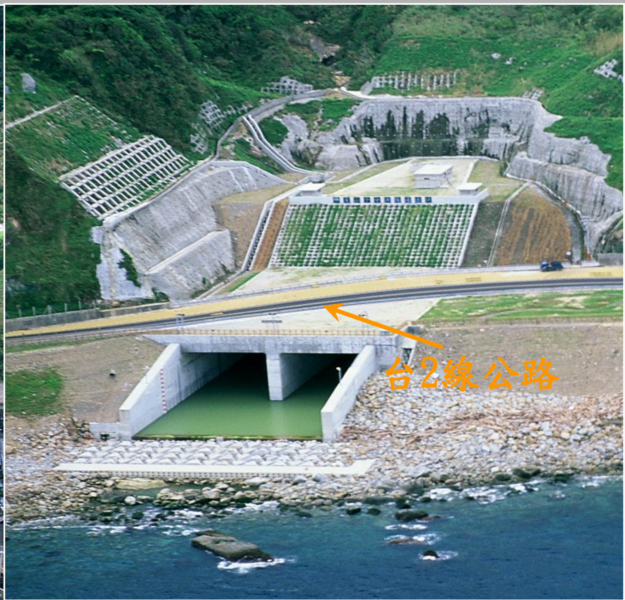
員山子分洪隧道出口全景
