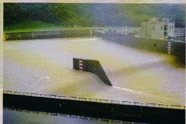
水位超過63公尺後，洪水溢流進入分洪隧道
