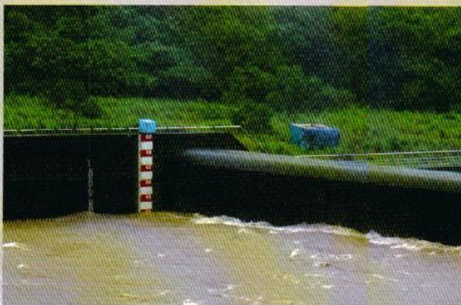
攔河堰體上水位高度尺標
