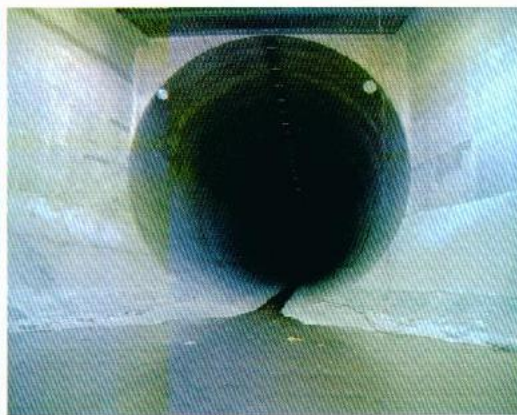
隧道出口漸變段
