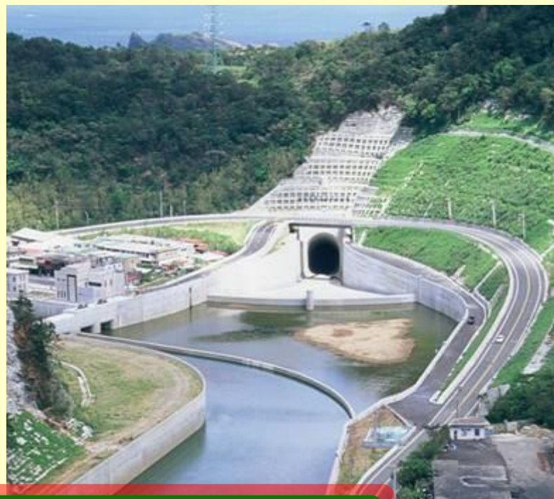
基隆河員山子分洪工程
