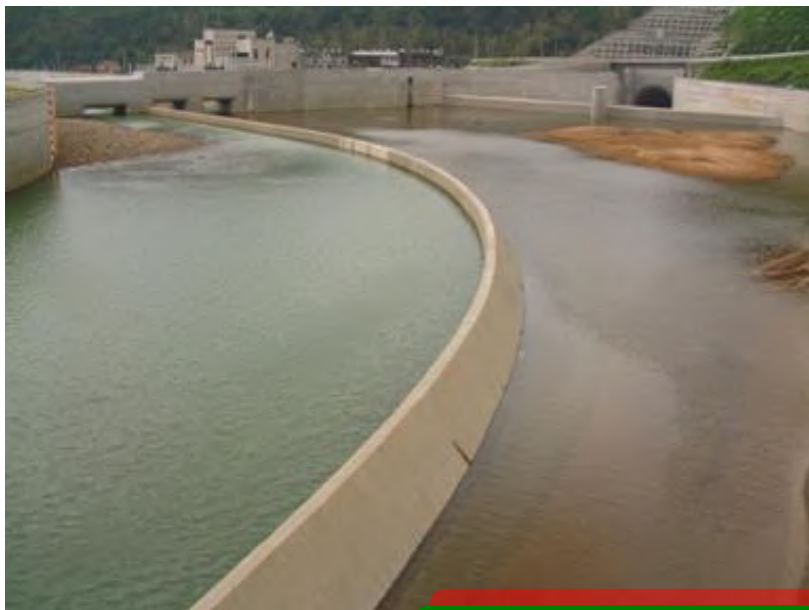
員山子分洪進水口
