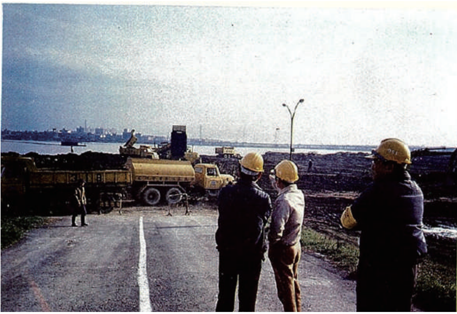
疏洪道河道清理施工情形 資料來源:經濟部水利署第十河川局
