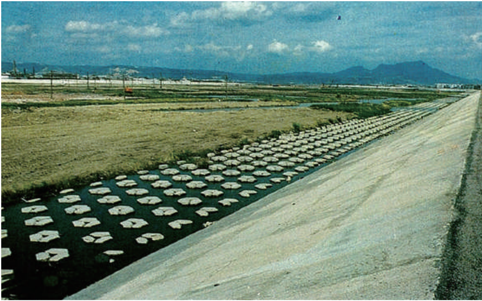
疏洪道堤防施工情形 資料來源:經濟部水利署第十河川局
