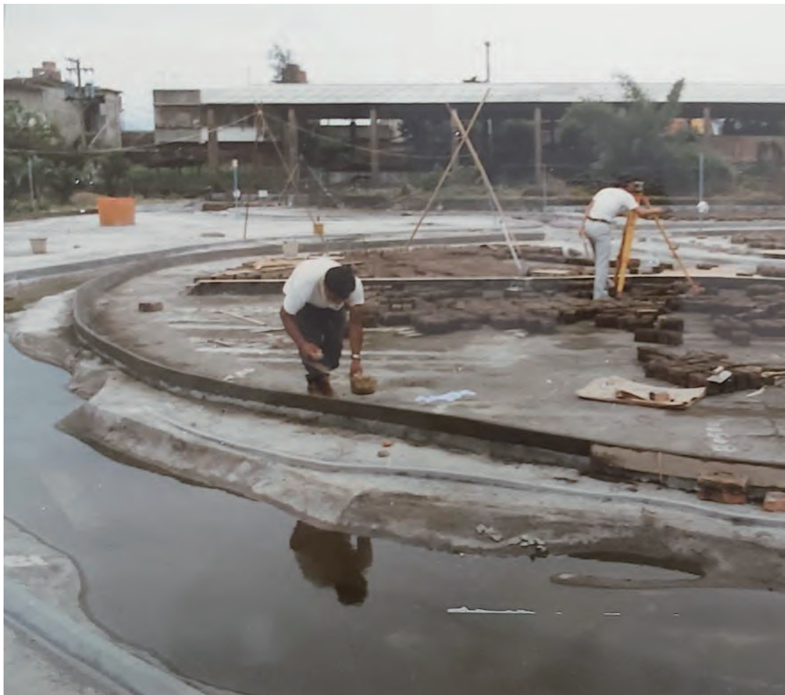
水工模型堤防建造過程 資料來源:經濟部水利署
