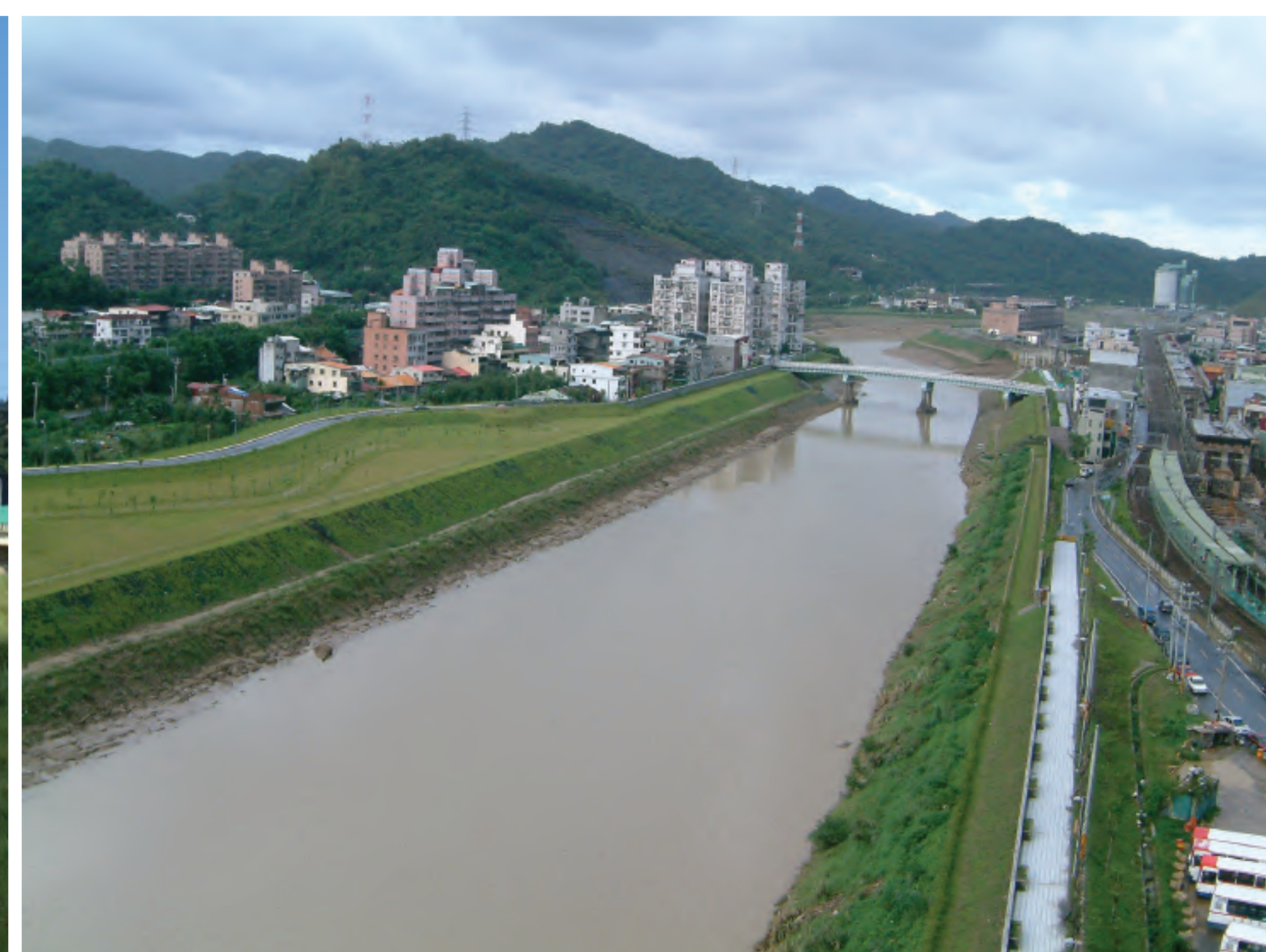
汐止段長安橋下游完工照 資料來源:經濟部水利署第十河川局
