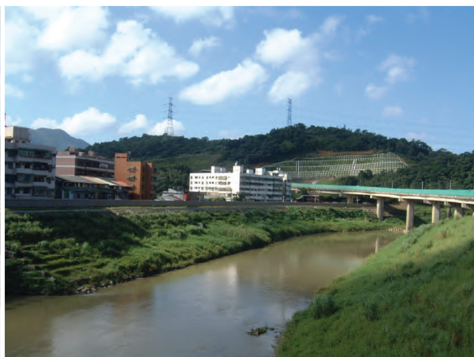
基隆段五堵堤防完工照 資料來源:經濟部水利署第十河川局
