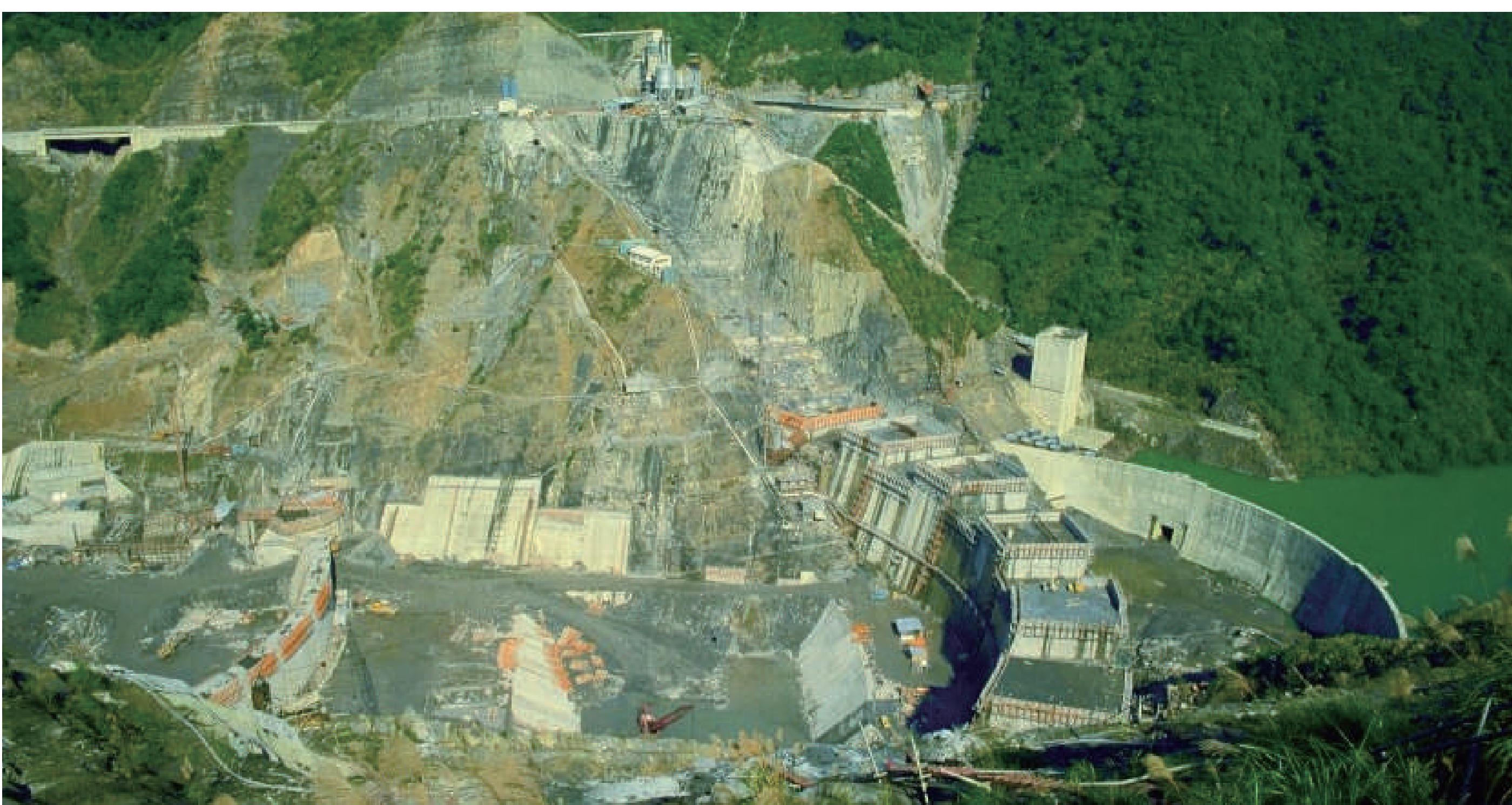
施工中的翡翠大壩 資料來源:臺北市府翡翠水庫管理局
