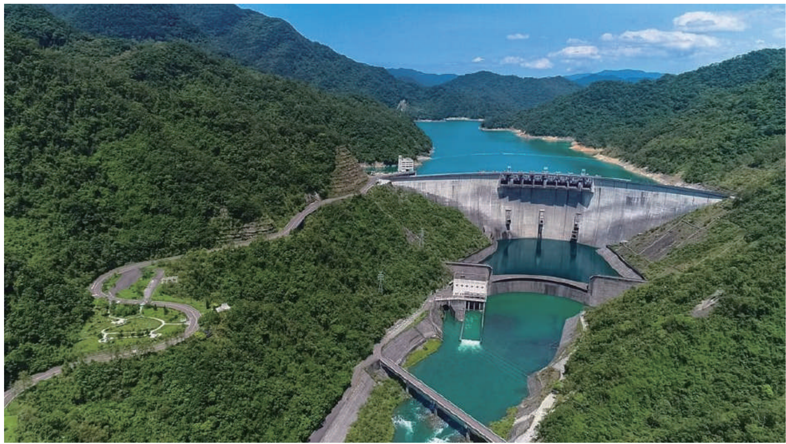
翡翠水庫現況一景 資料來源:臺北市府翡翠水庫管理局
