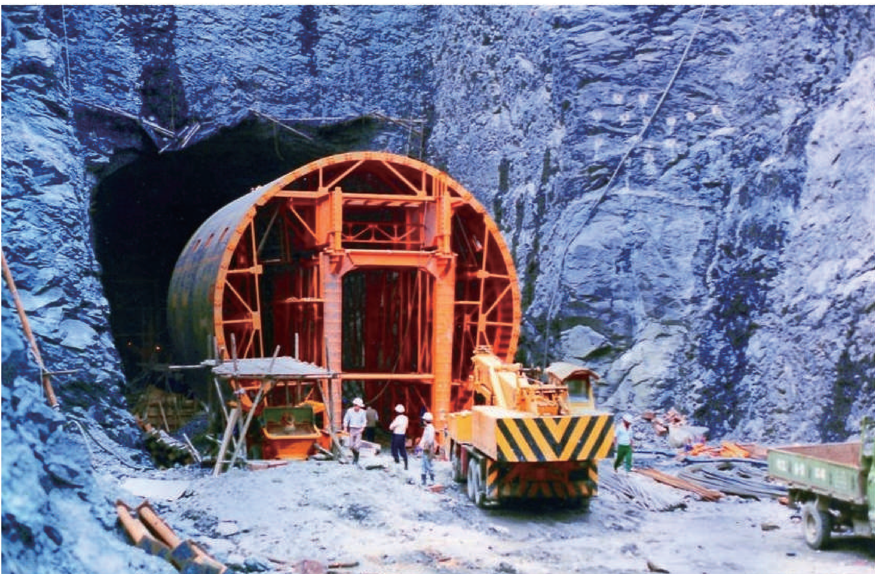
導水隧道施工情形 資料來源:臺北市府翡翠水庫管理局
