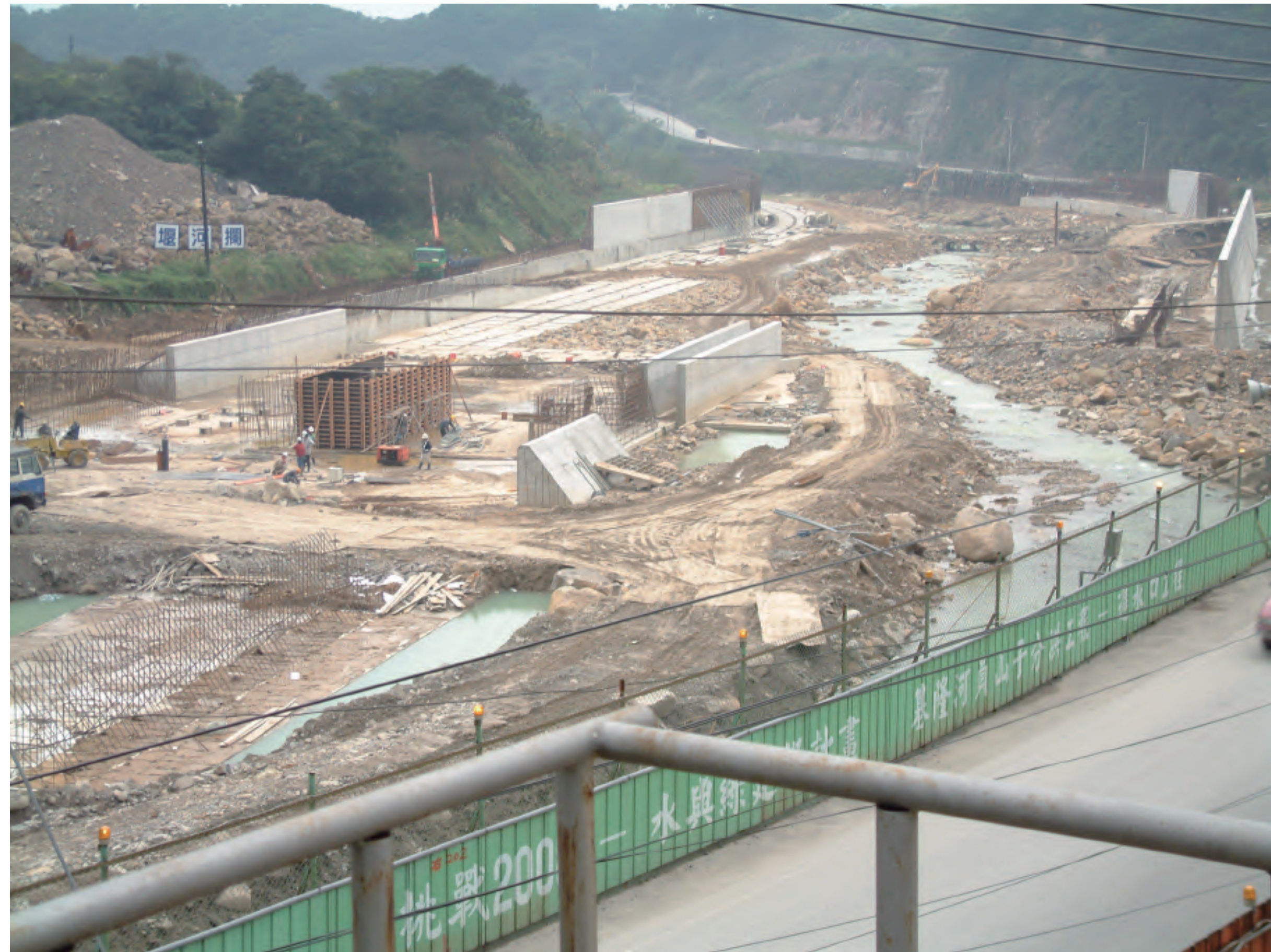
員山子河道攔河堰施工照片
