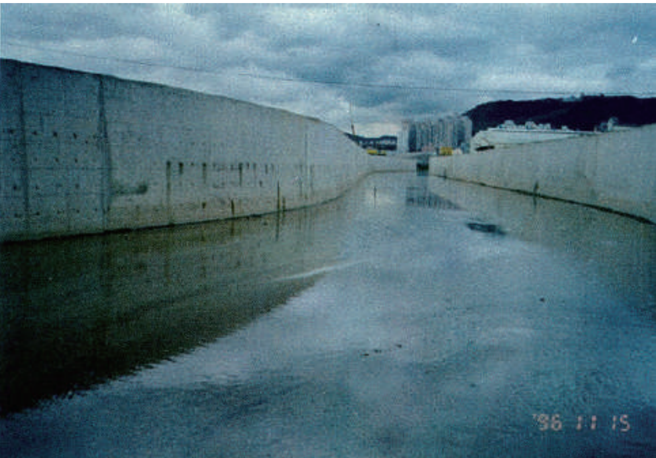
五股坑溪連繫堤防工程
