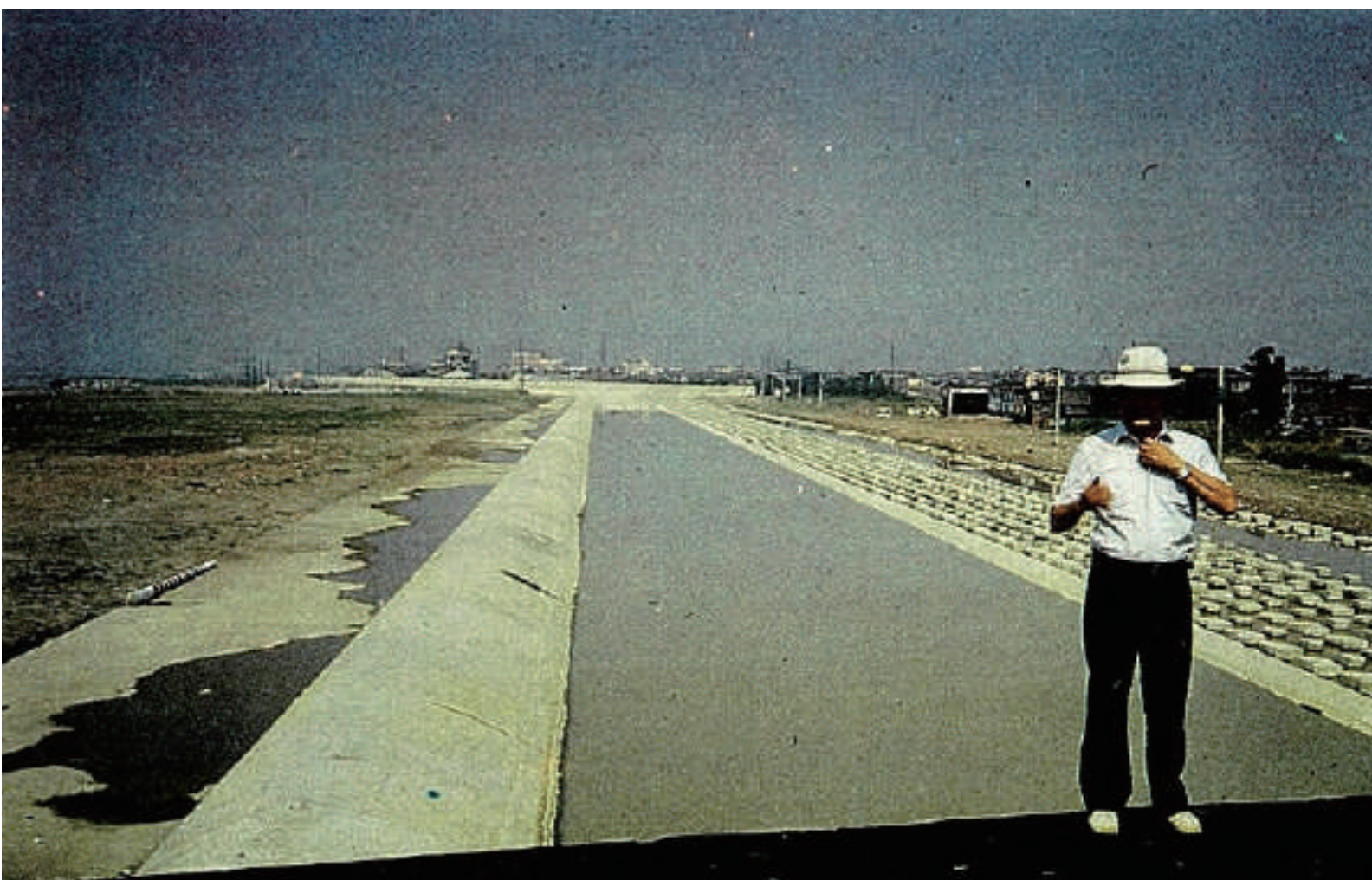
疏洪道固定堰完工照 資料來源:經濟部水利署第十河川局
