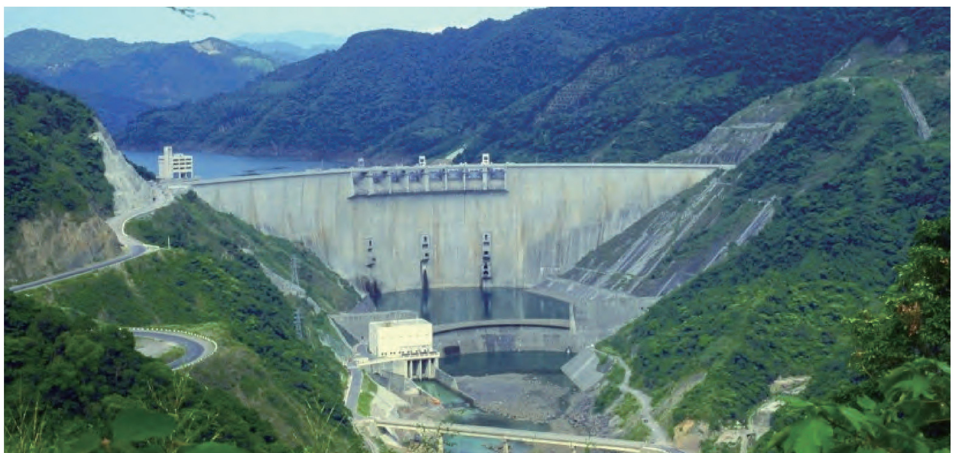
翡翠大壩完工照 資料來源:臺北市府翡翠水庫管理局
