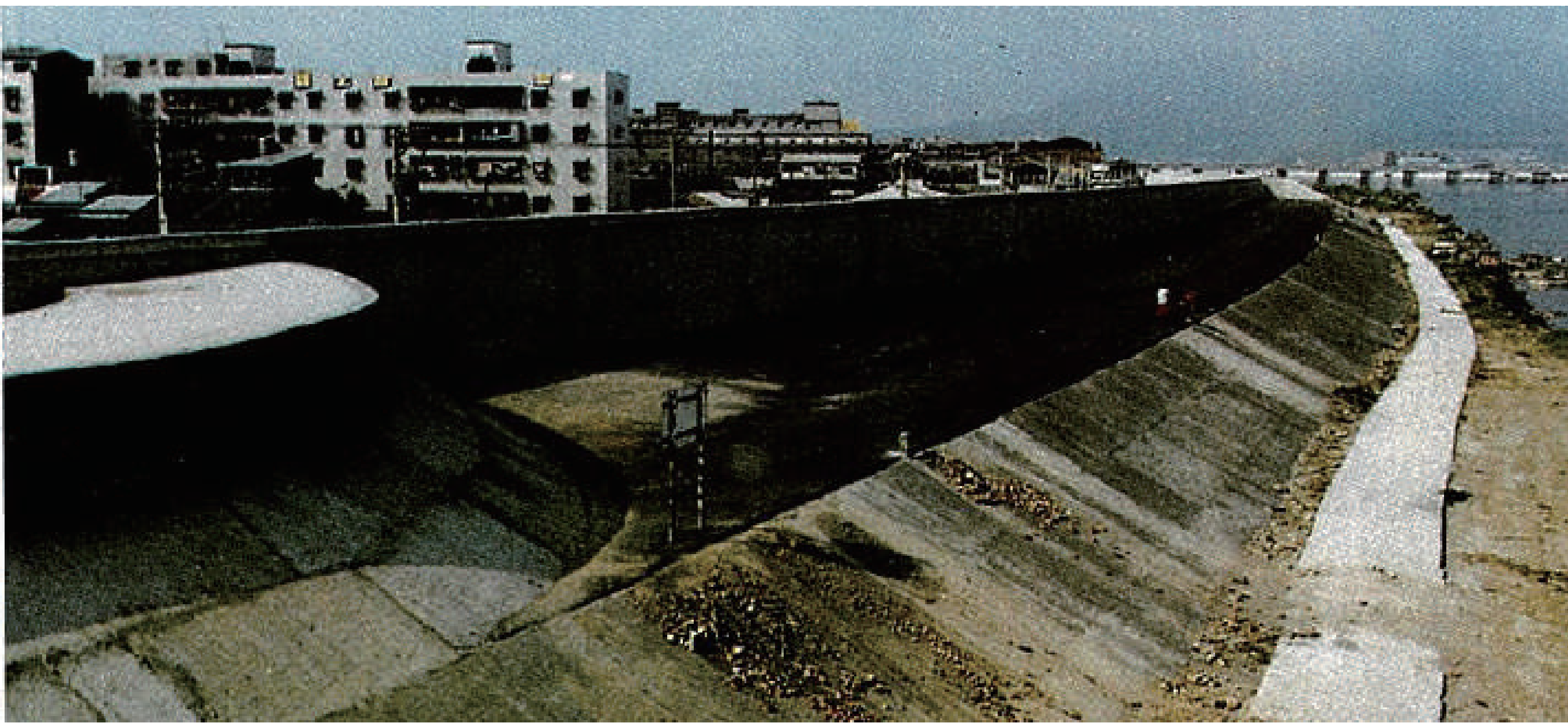
防洪牆施工情形
