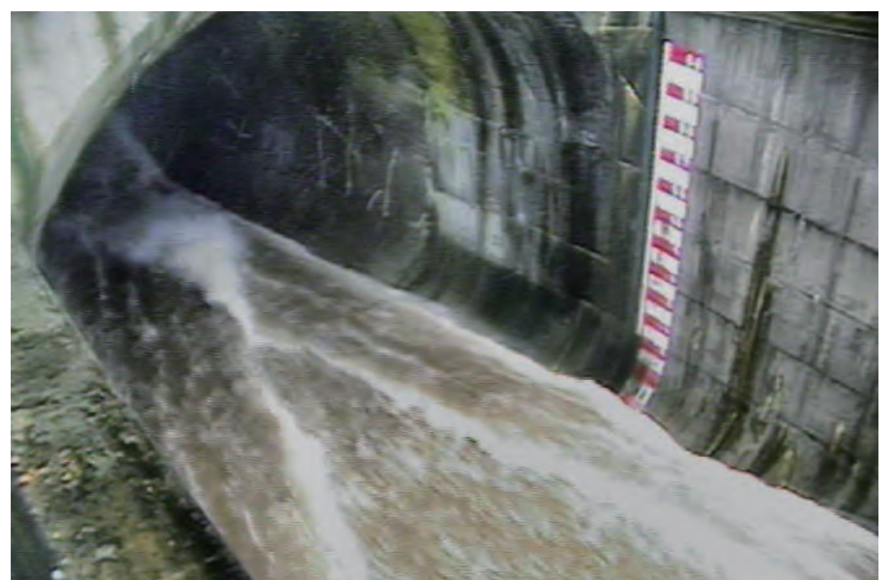
排洪隧道入水口
