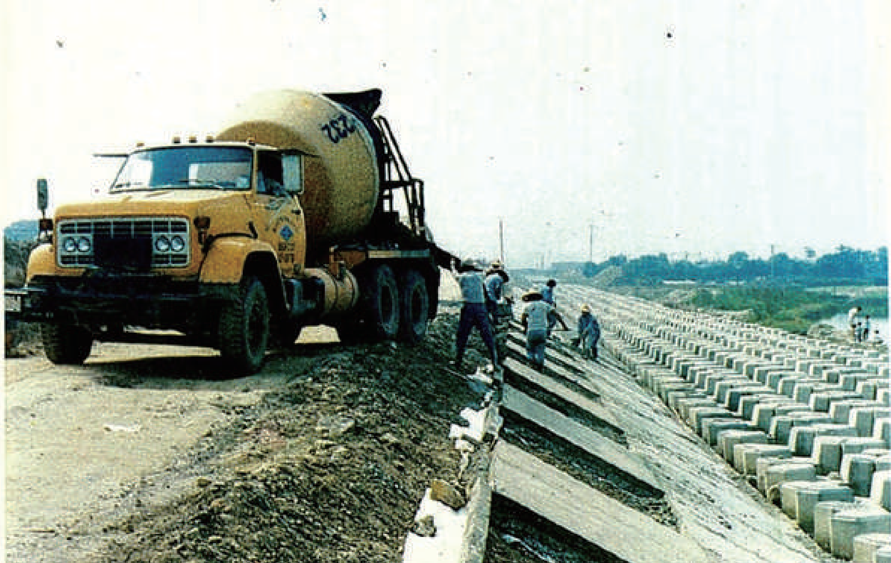
疏洪道右岸堤防施工情形 資料來源:經濟部水利署第十河川局
