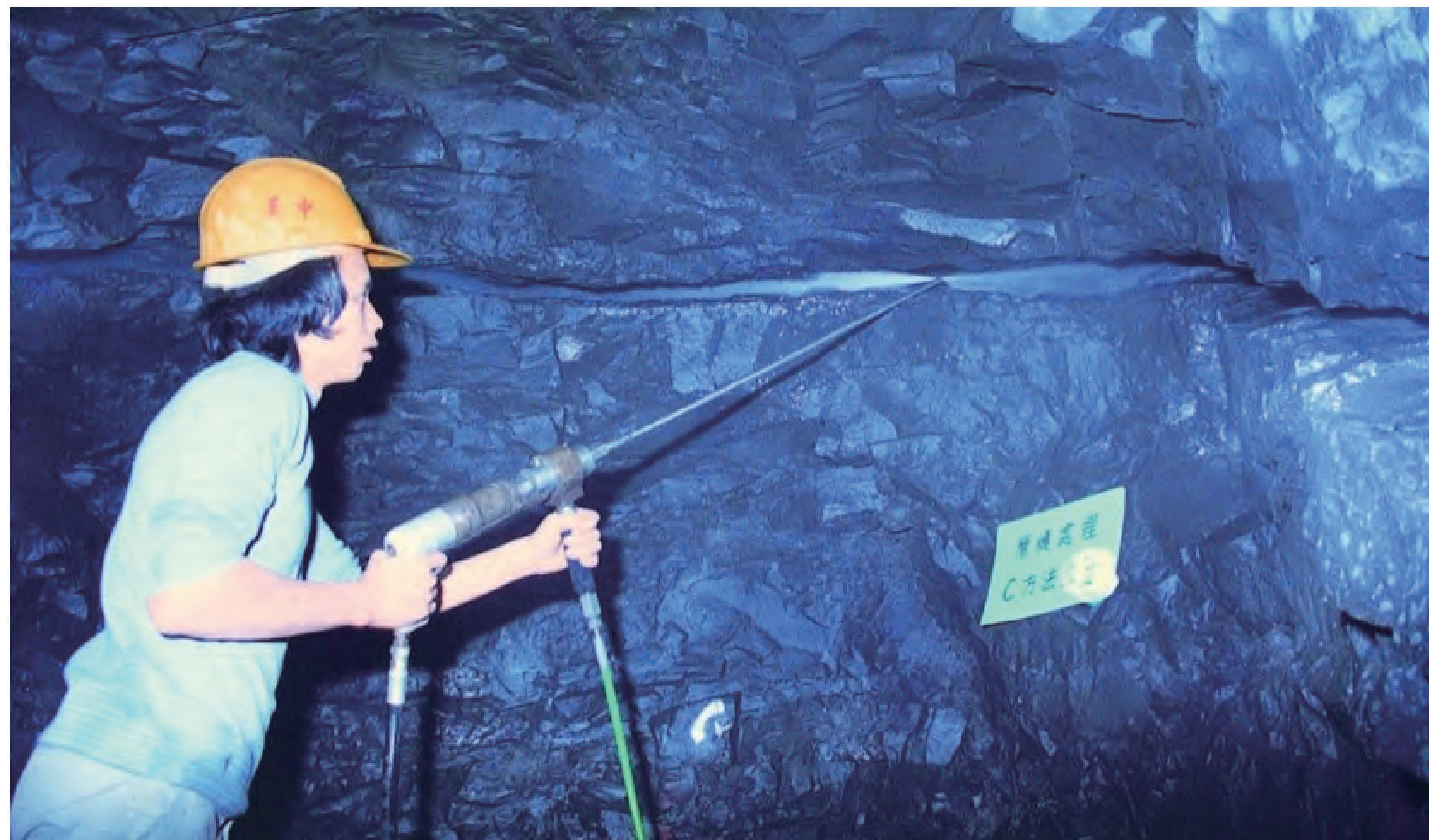
使用水刀沖洗含泥沙層縫情形 資料來源:臺北市府翡翠水庫管理局
