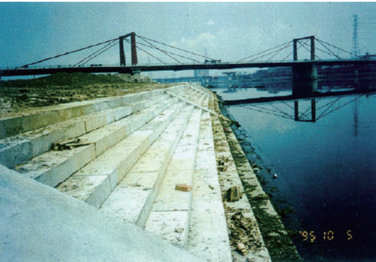
堤防工程施工情形
