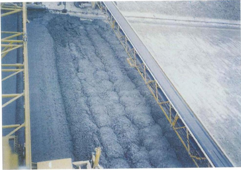
(圖五) 啓動鋪築機，鋪設坡面上
