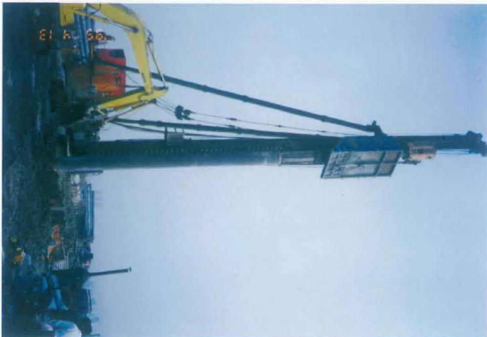
防洪工程 (中掘式預植樁施工)
