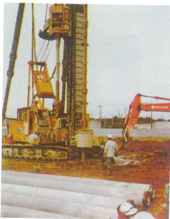
步驟① 預鑽式根固工法（泥漿工法）樁孔鑽掘
