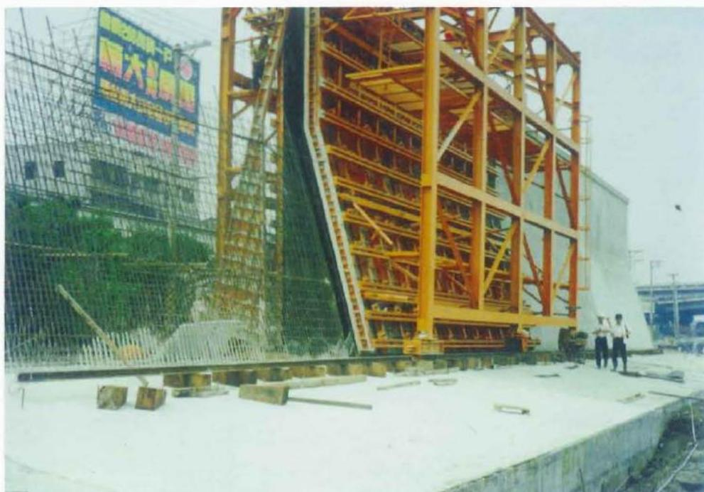
防洪工程（防牆鋼模施工）
