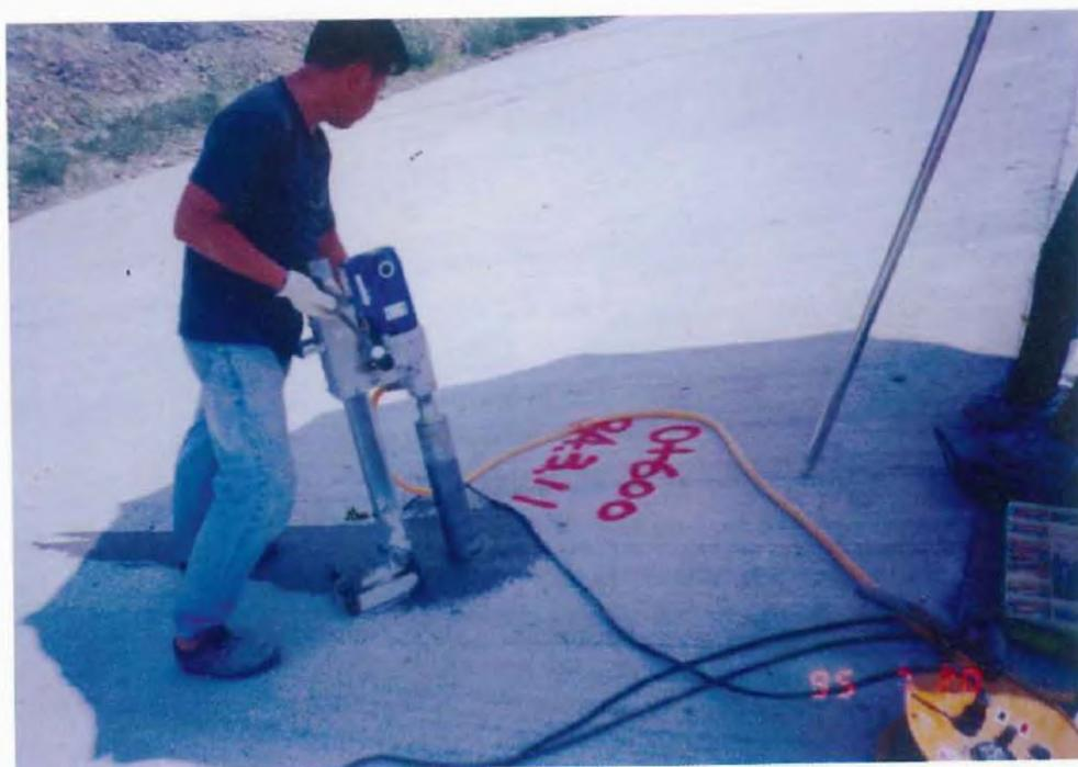
防洪工程（混凝土鑽心試驗）
