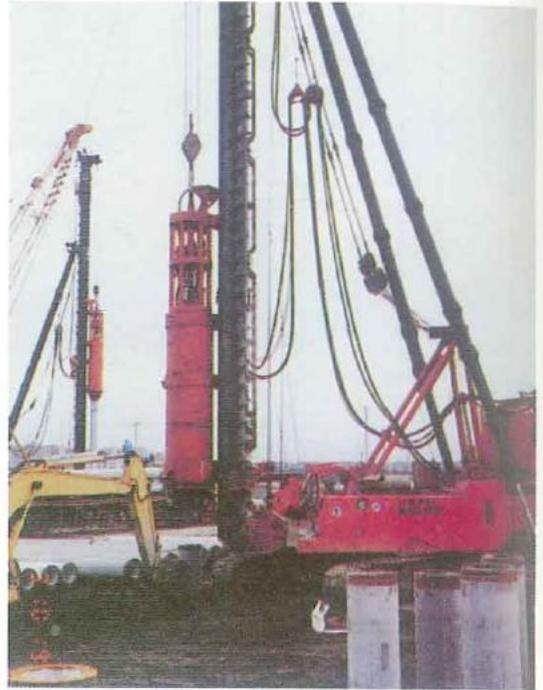
步驟④ PC樁末端以回轉埋設 PC樁末端以油壓樁錘打入至預定深度
