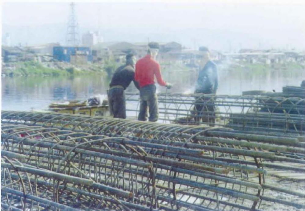
堤防工程（反循環樁施工）
