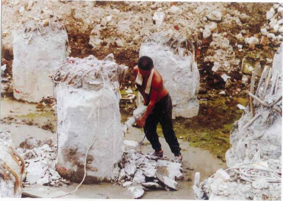
堤防工程（反循環樁施工）
