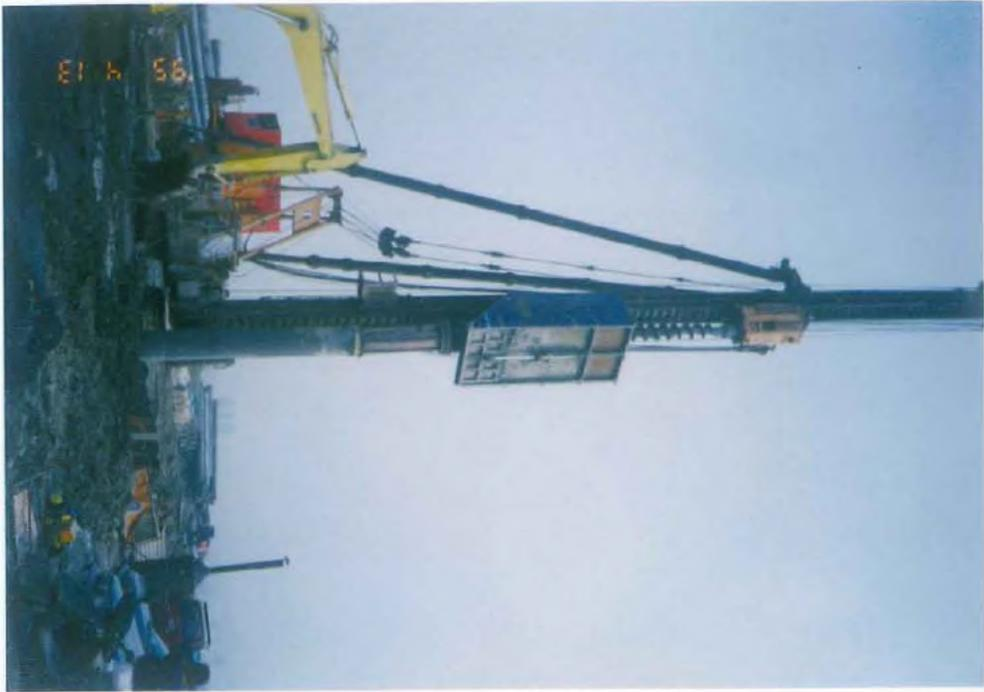
防洪工程（中掘式預植樁施工）
