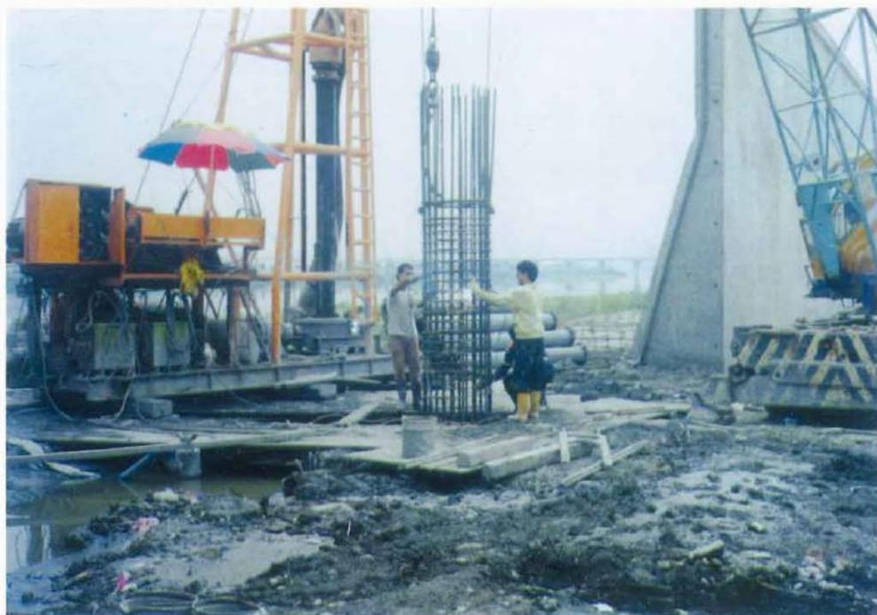
堤防工程（反循環樁施工）
