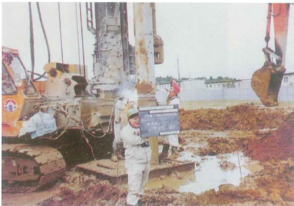
步驟③ 上，下基樁電焊接樁
