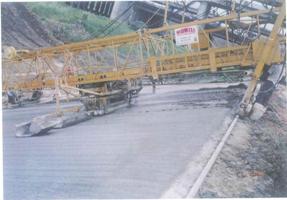
(圖九) 第二道壓實作業 (圓柱滾筒二支)
