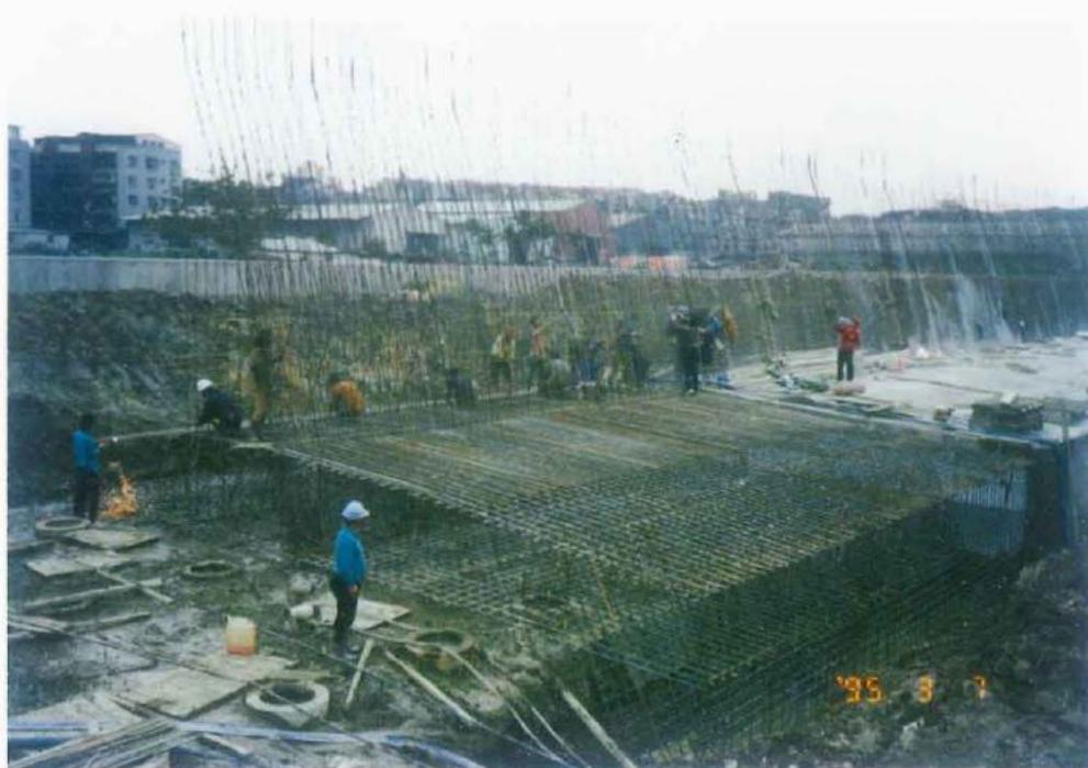
防洪工程（防洪牆鋼筋施工）
