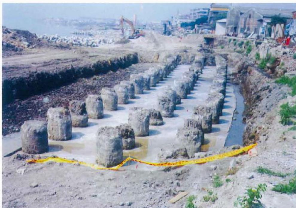
堤防工程（反循環樁施工）
