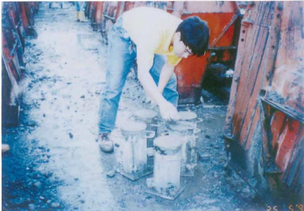
防洪工程（混凝土試體製作）
