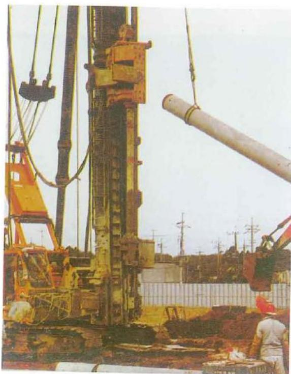
步驟② 右圖 樁孔鑽掘完成，吊放PC樁準備植入PC樁
