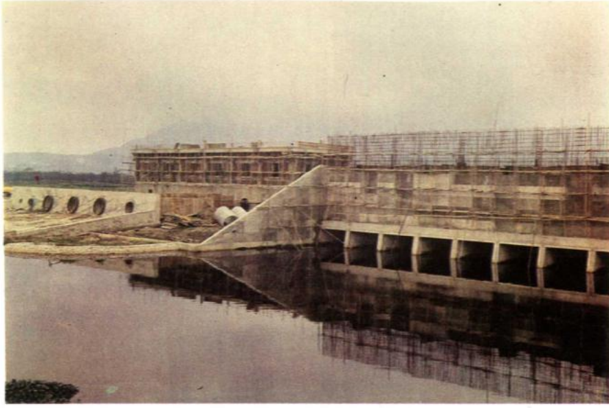
鴨母港排水閘門施工中
