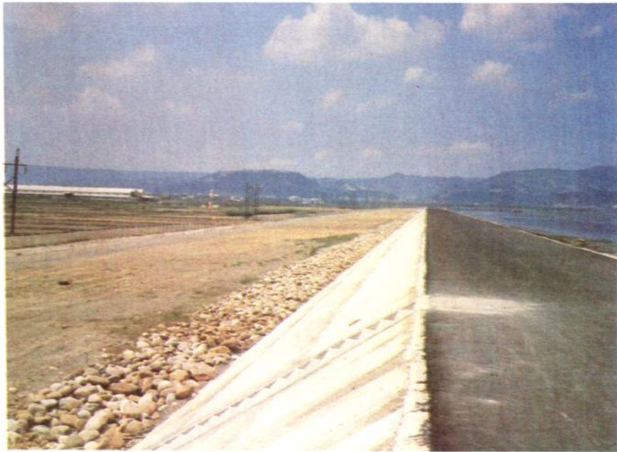
蘆洲堤防施工後
