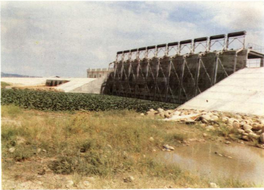
鴨母港排水閘門施工後
