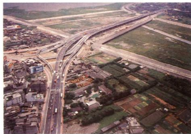
二重疏洪道高架橋鳥瞰
