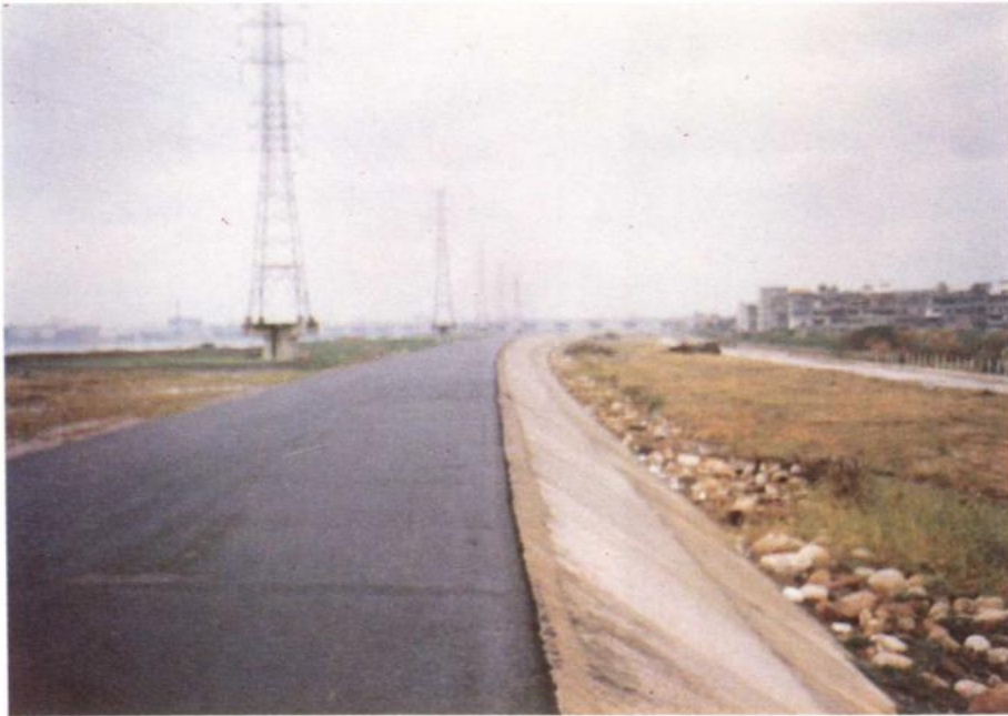
蘆洲堤防施工後
