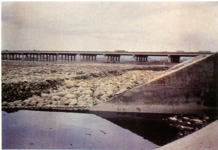
三重堤防高速公路旁垃圾山施工後
