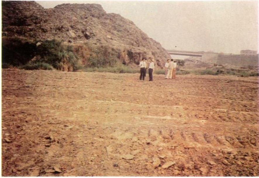
三重堤防高速公路旁垃圾山施工前
