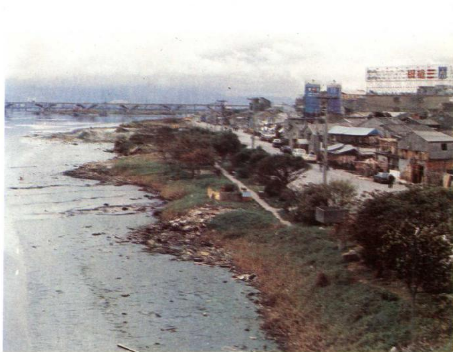
三重堤防台北橋處施工前
