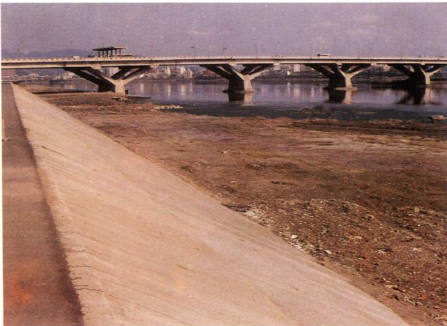
三重堤防忠孝橋處施工後
