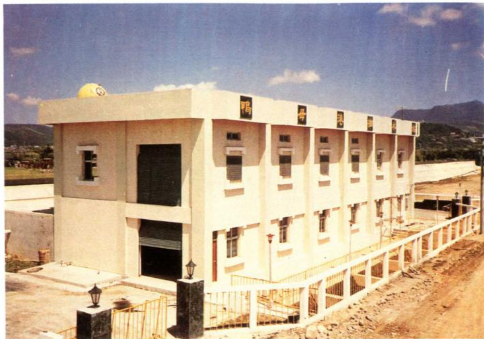
鴨 母 港 抽 水 站
