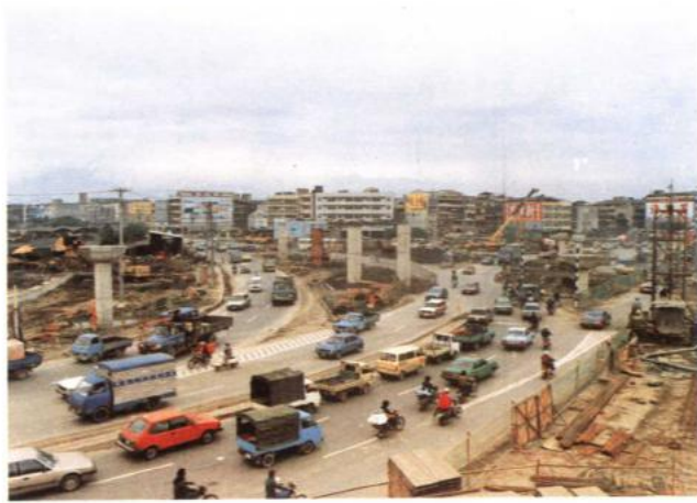
二重疏洪道高架橋施工中
