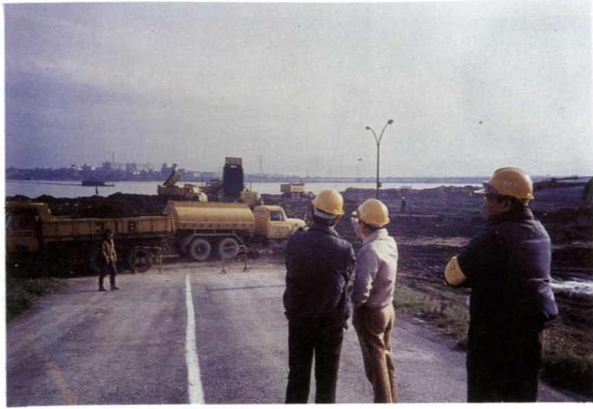
疏洪道堤防施工中
