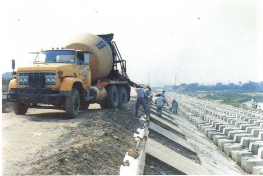
疏洪道右岸堤防施工中
