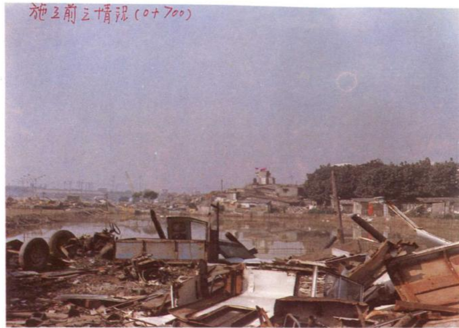
三重堤防中興橋處施工前
