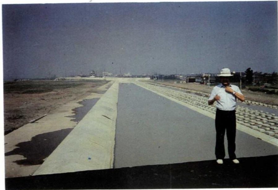
疏洪道入口固定堰完工照
