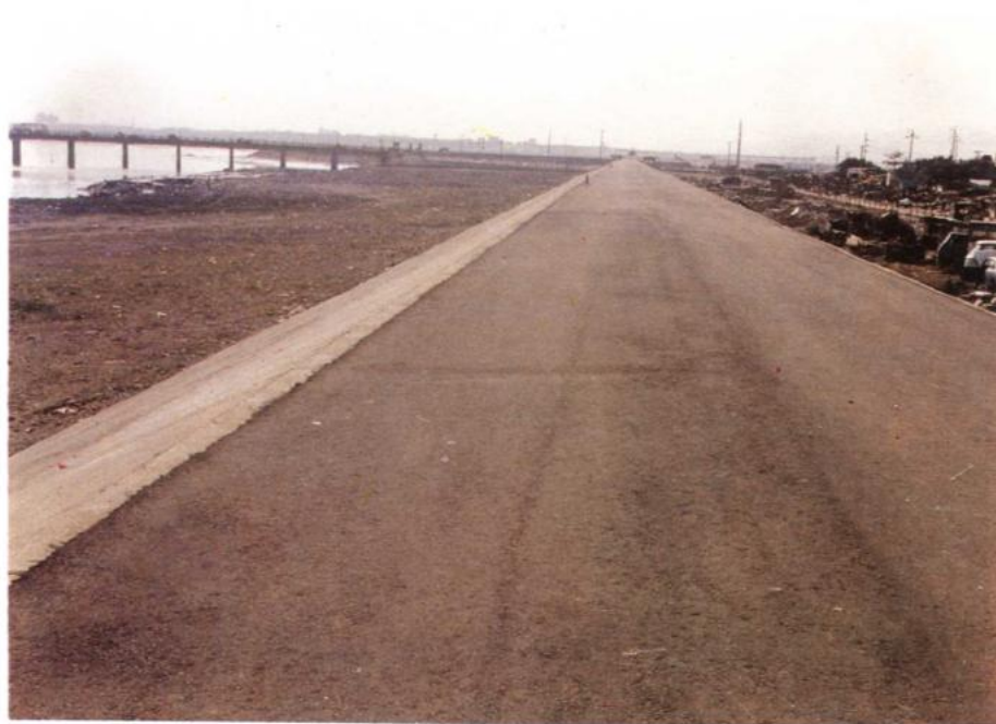
三重堤防中興橋處施工後
