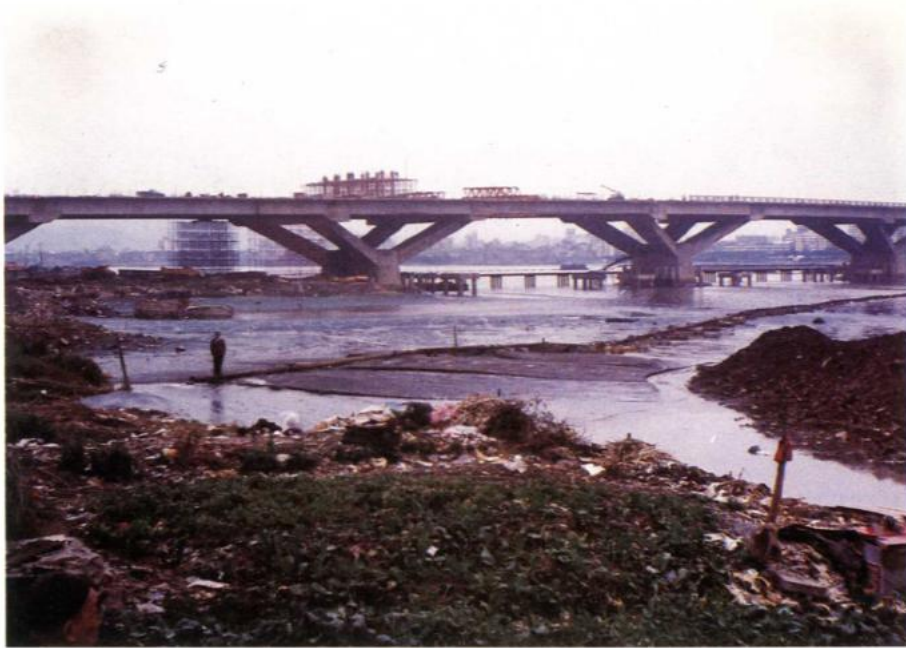
三重堤防忠孝橋處施工前
