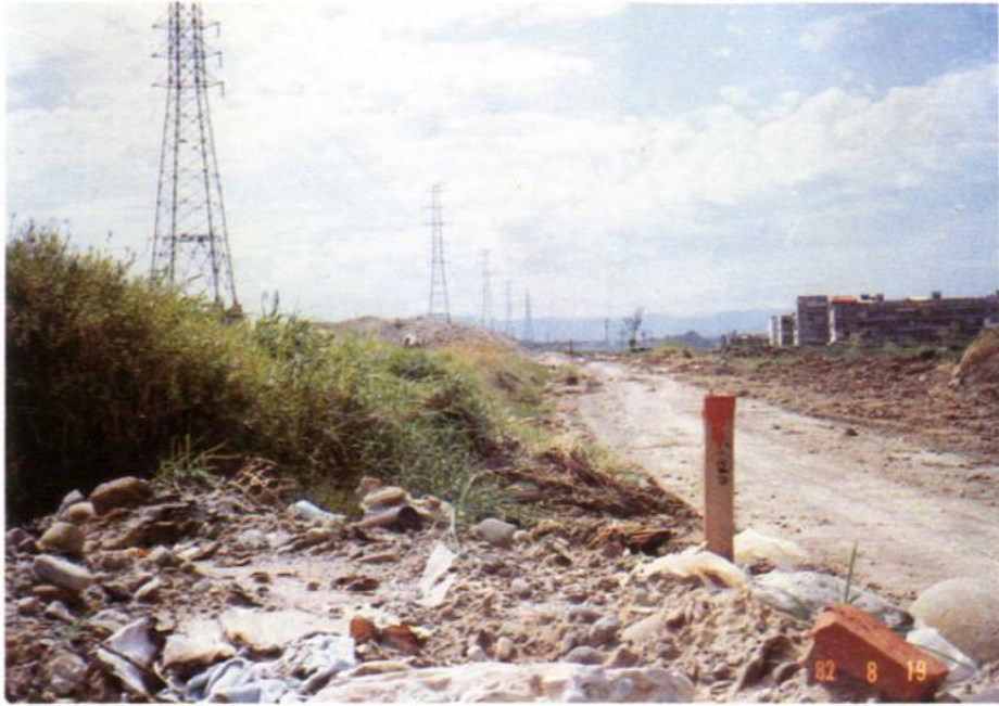
蘆洲堤防施工前
