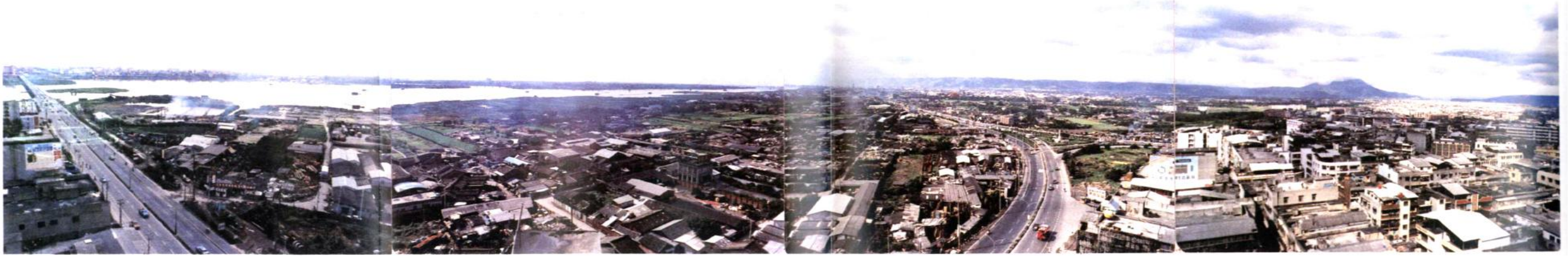
二重疏洪道施工前
