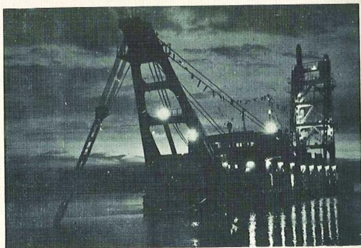
挖泥船漏夜趕工
