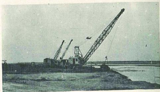
浚渫施工情形
