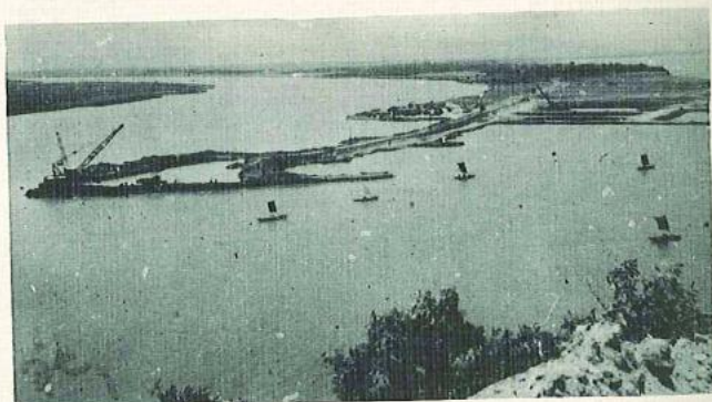
浚渫施工之二
