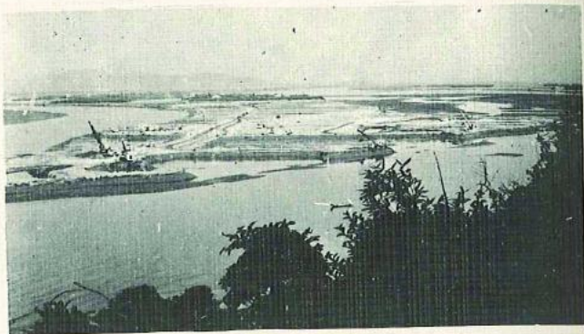
浚渫施工情形
