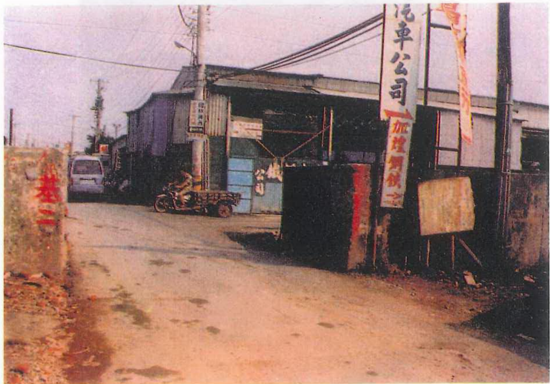
照22 撫遠擋水牆 2 號水門路坎高過閘門底
