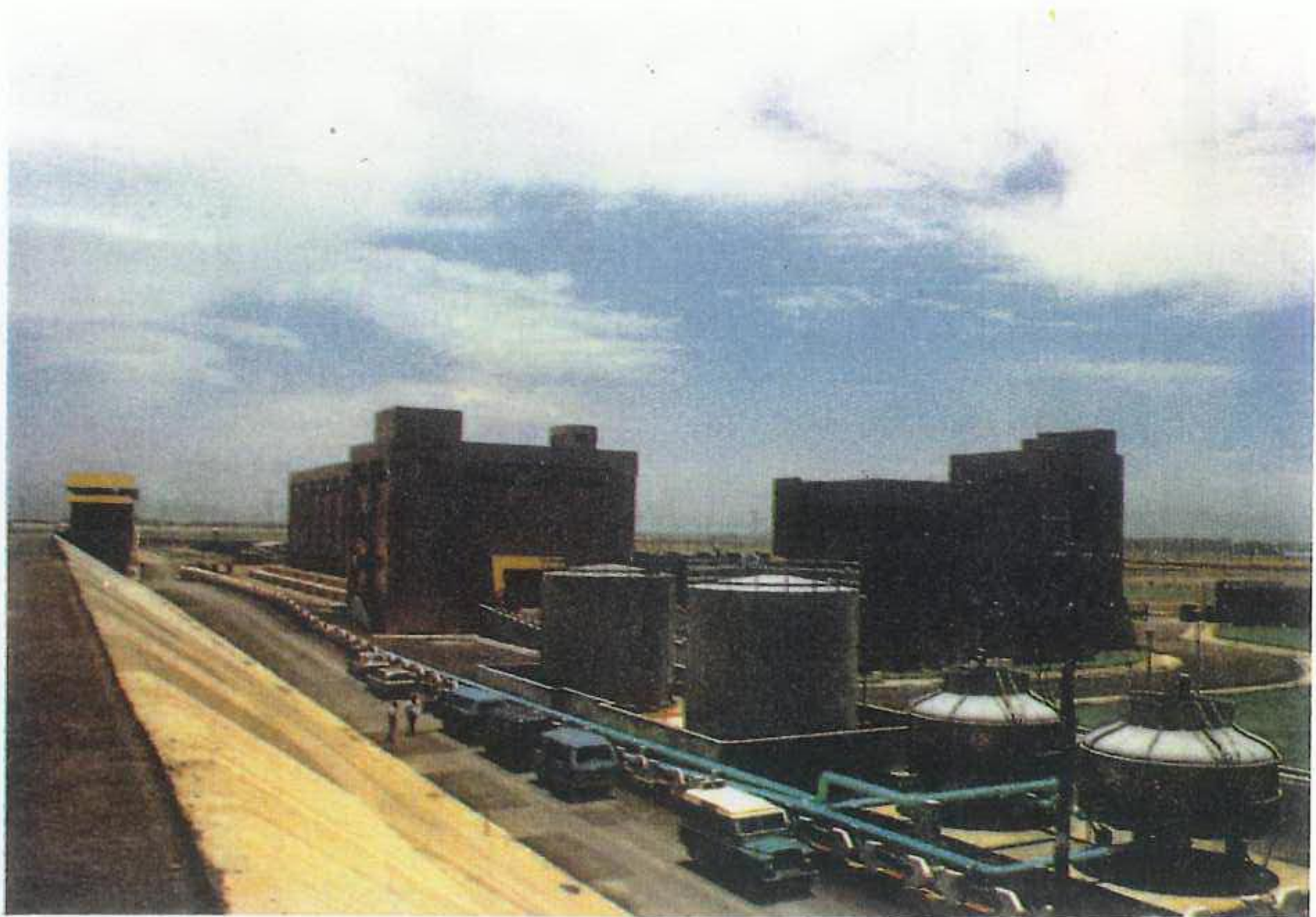
照20 中港抽水站
