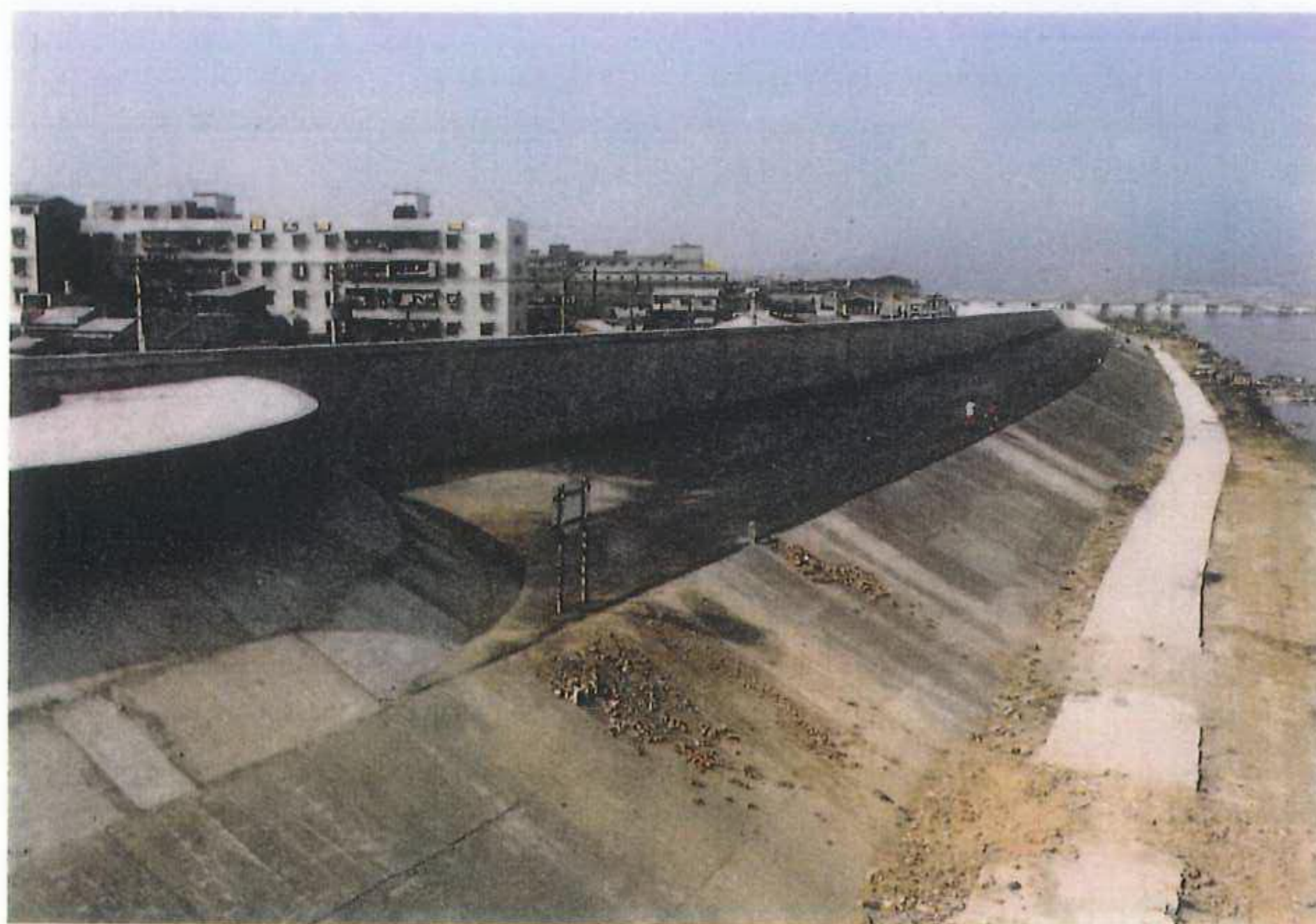
防洪牆(迎水面)完成
