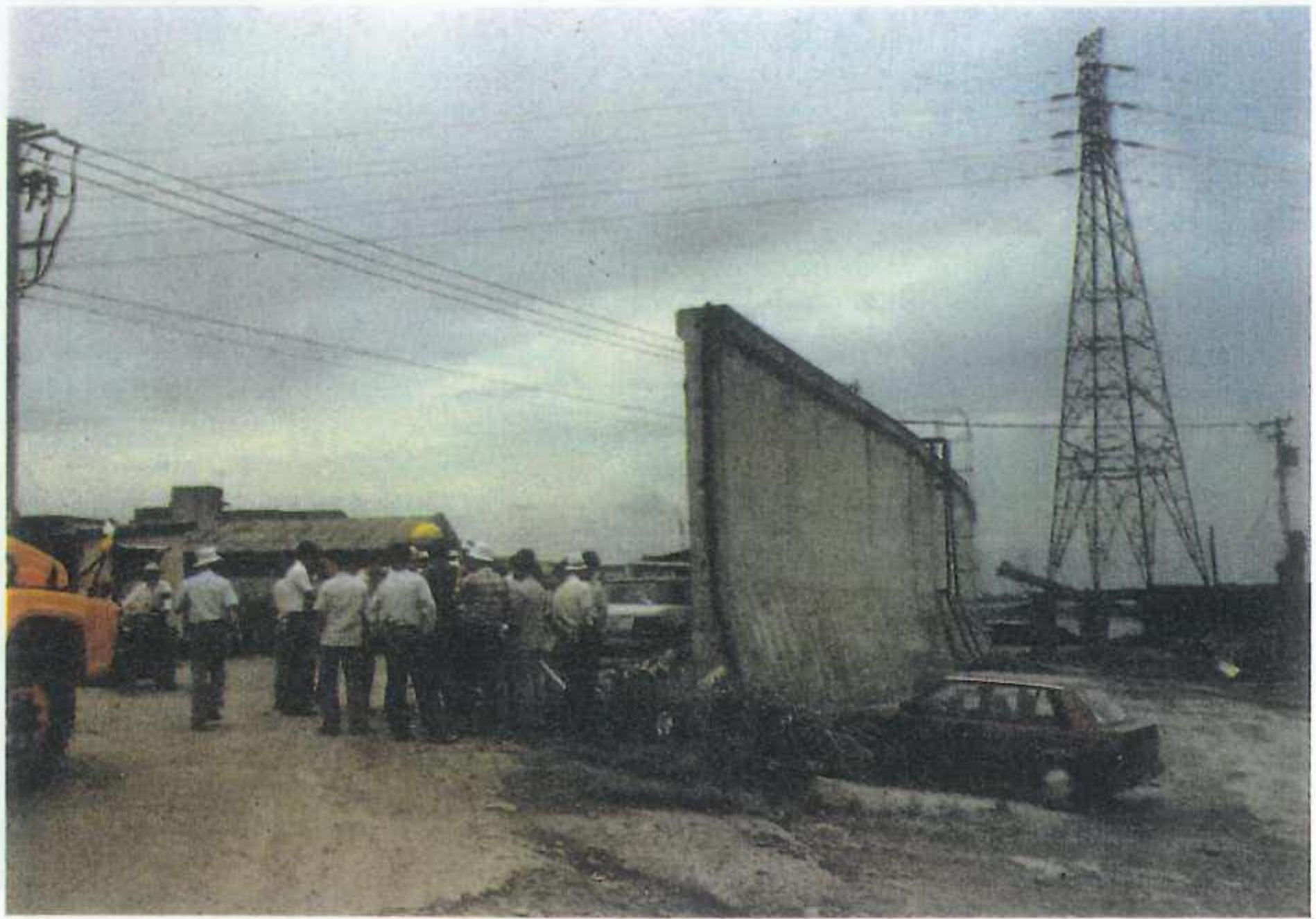
照17 渡頭堤防與社子島之缺口
