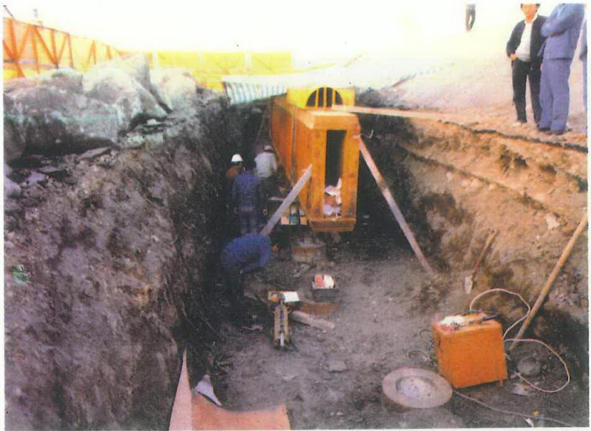
防洪牆基礎荷重試驗
