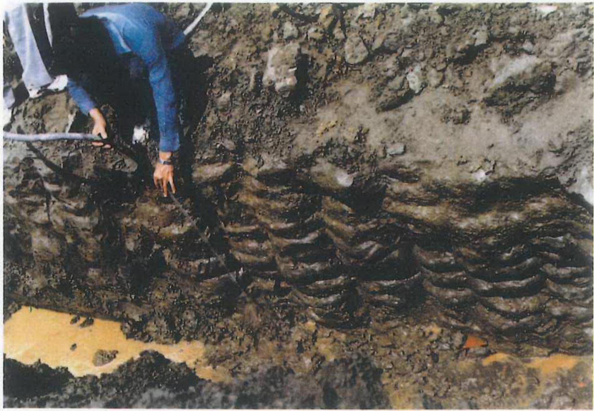
防洪牆前截水牆施工完成開挖檢驗
