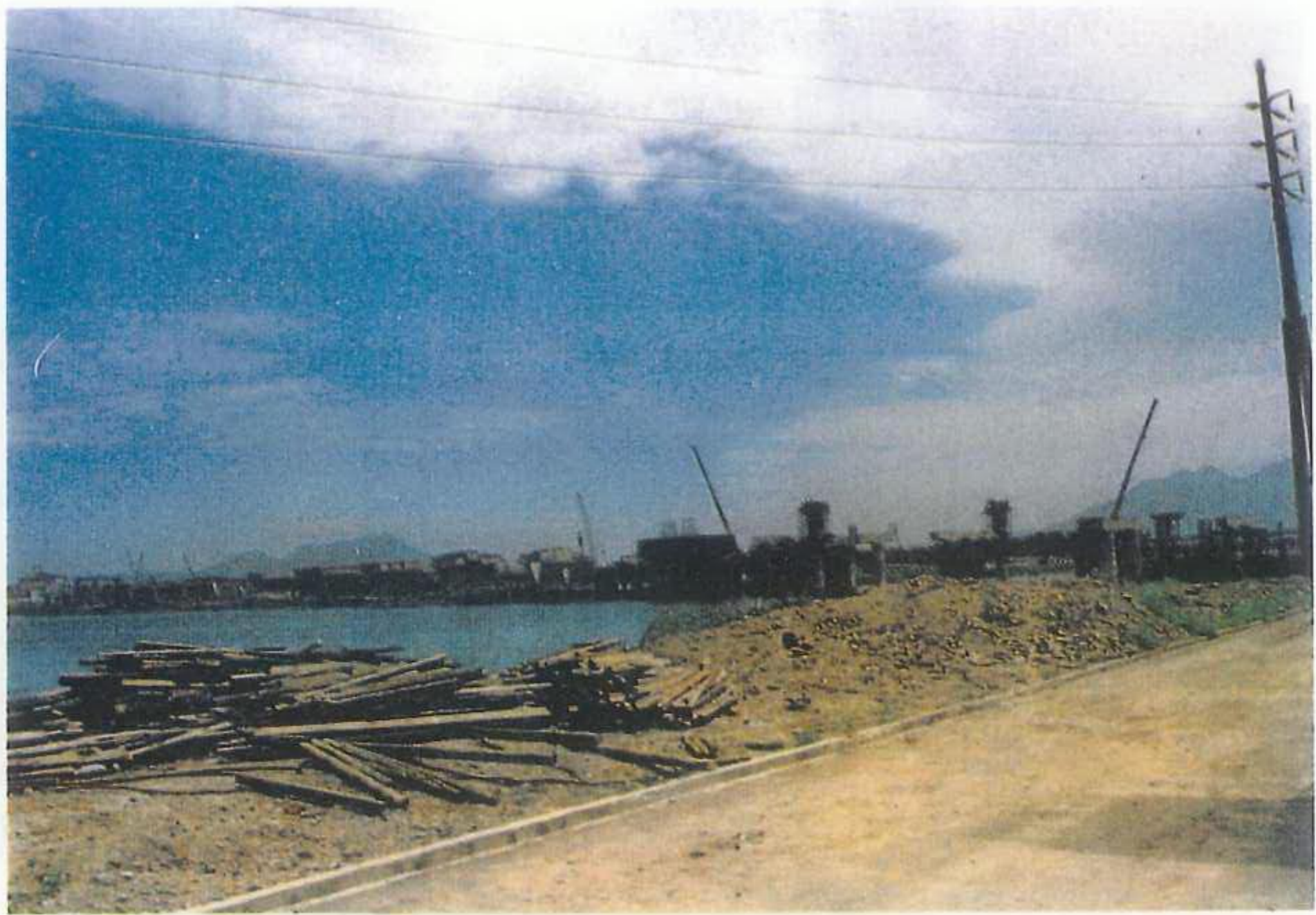
照21 中興大橋改建工程
