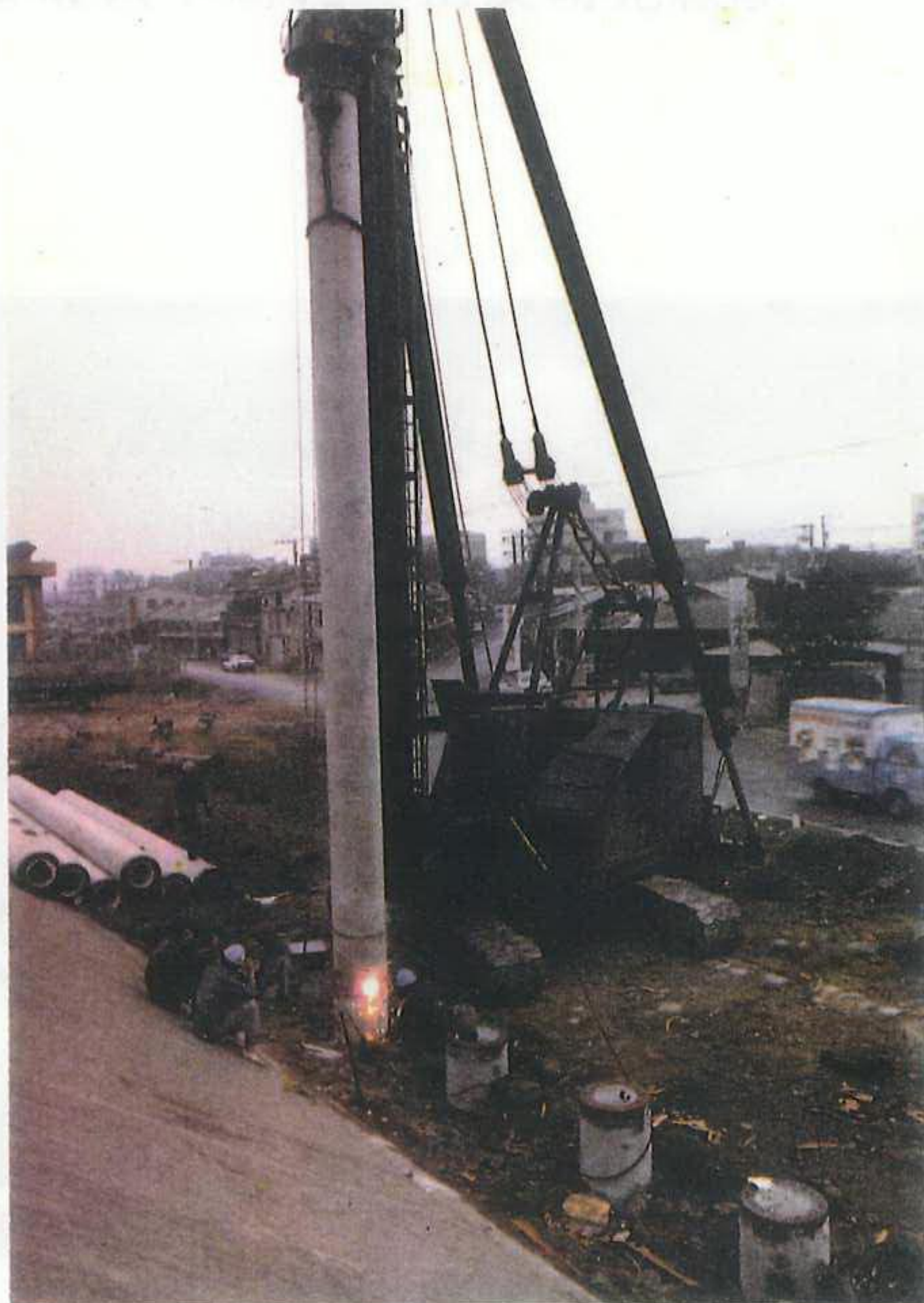
防洪牆基礎打設
