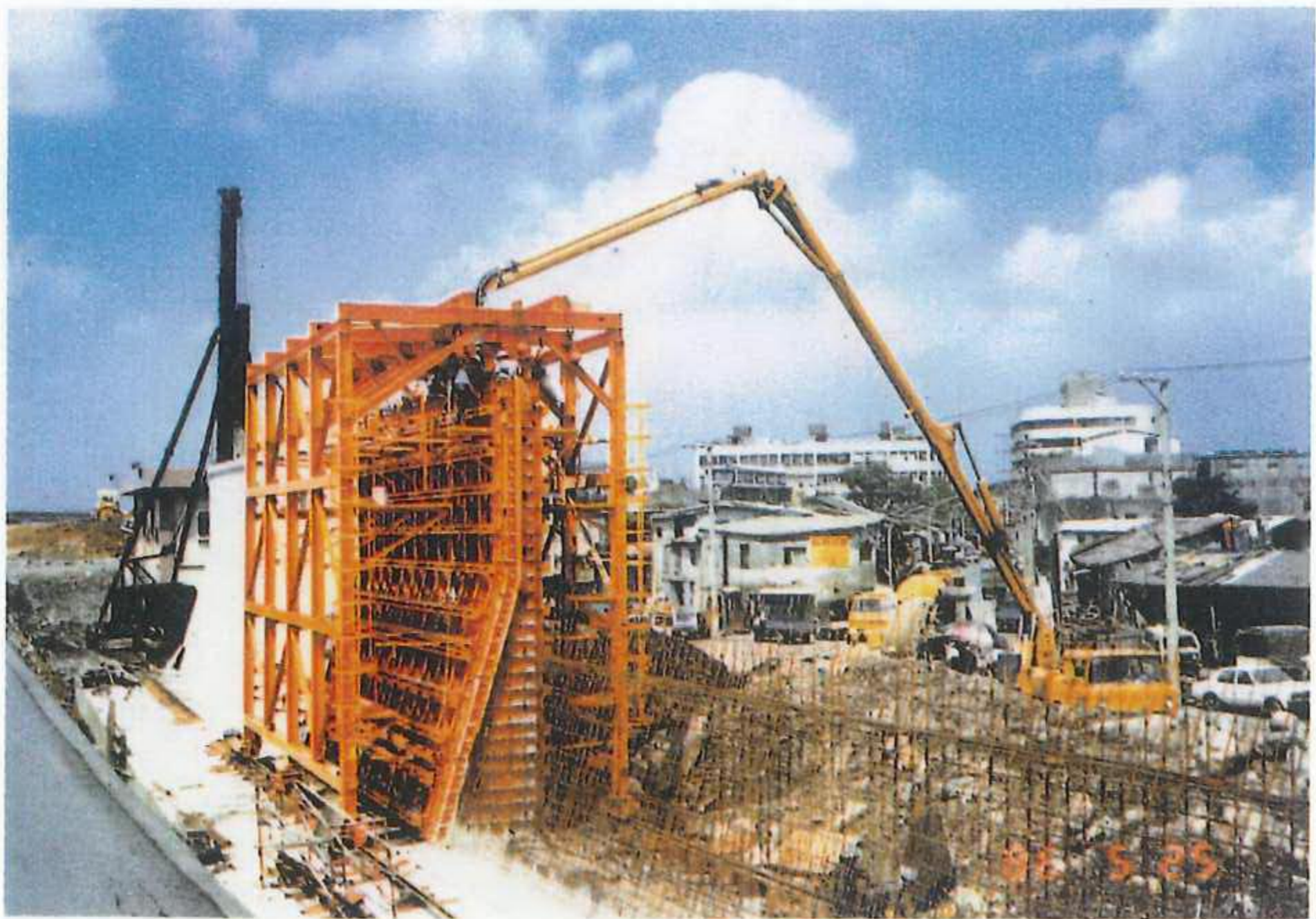
防洪牆施工(面)完成
