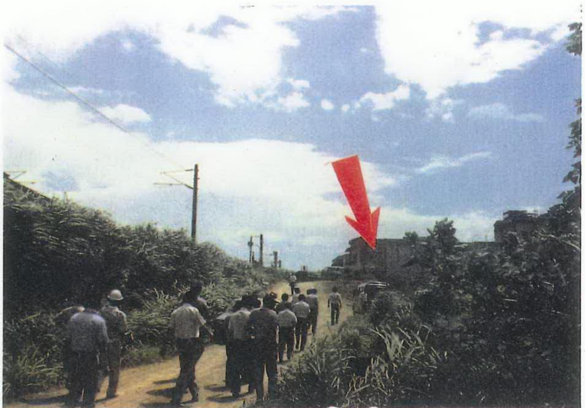
照18 台北市雙園堤防與鐵路橋缺口
