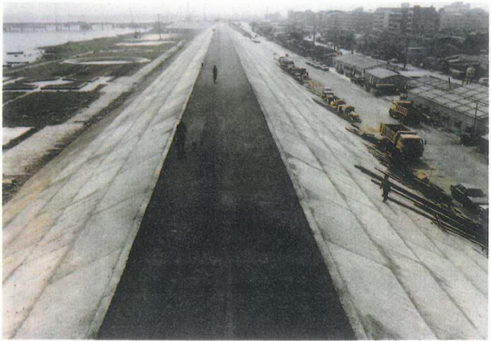
三重堤防完成實景
