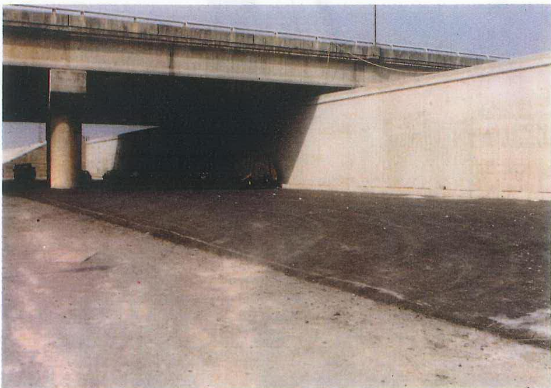
淡水河高速公路橋下堤防改爲防洪牆
