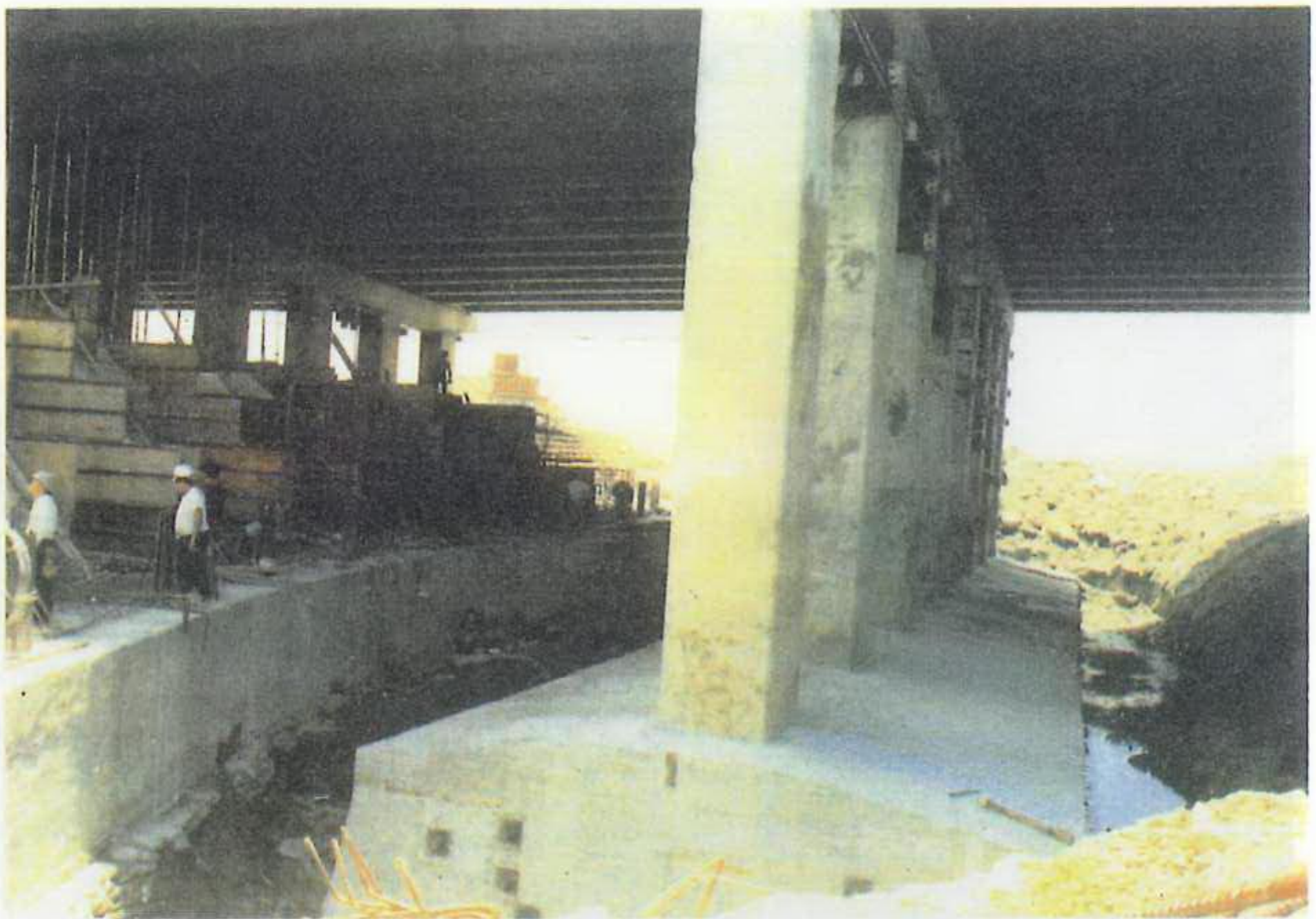
照16 高速公路洩洪橋加固工程(P.5.6.7)
