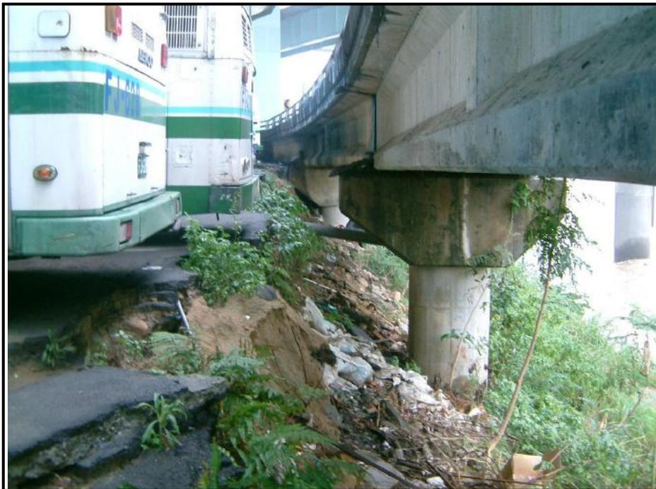
照片三 暖暖溪出口下游右岸河段遭沖蝕原有護岸崩塌情形
