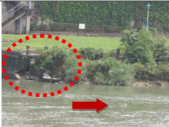
照片 2-44 斷面 35A 左岸坡址破壞情形
