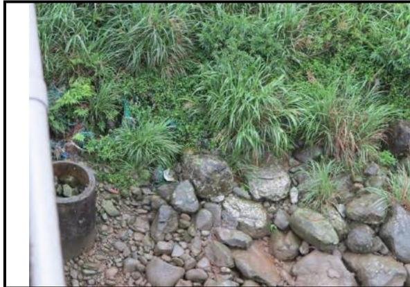
照片 2-1 断面 129 左岸石籠破壞
