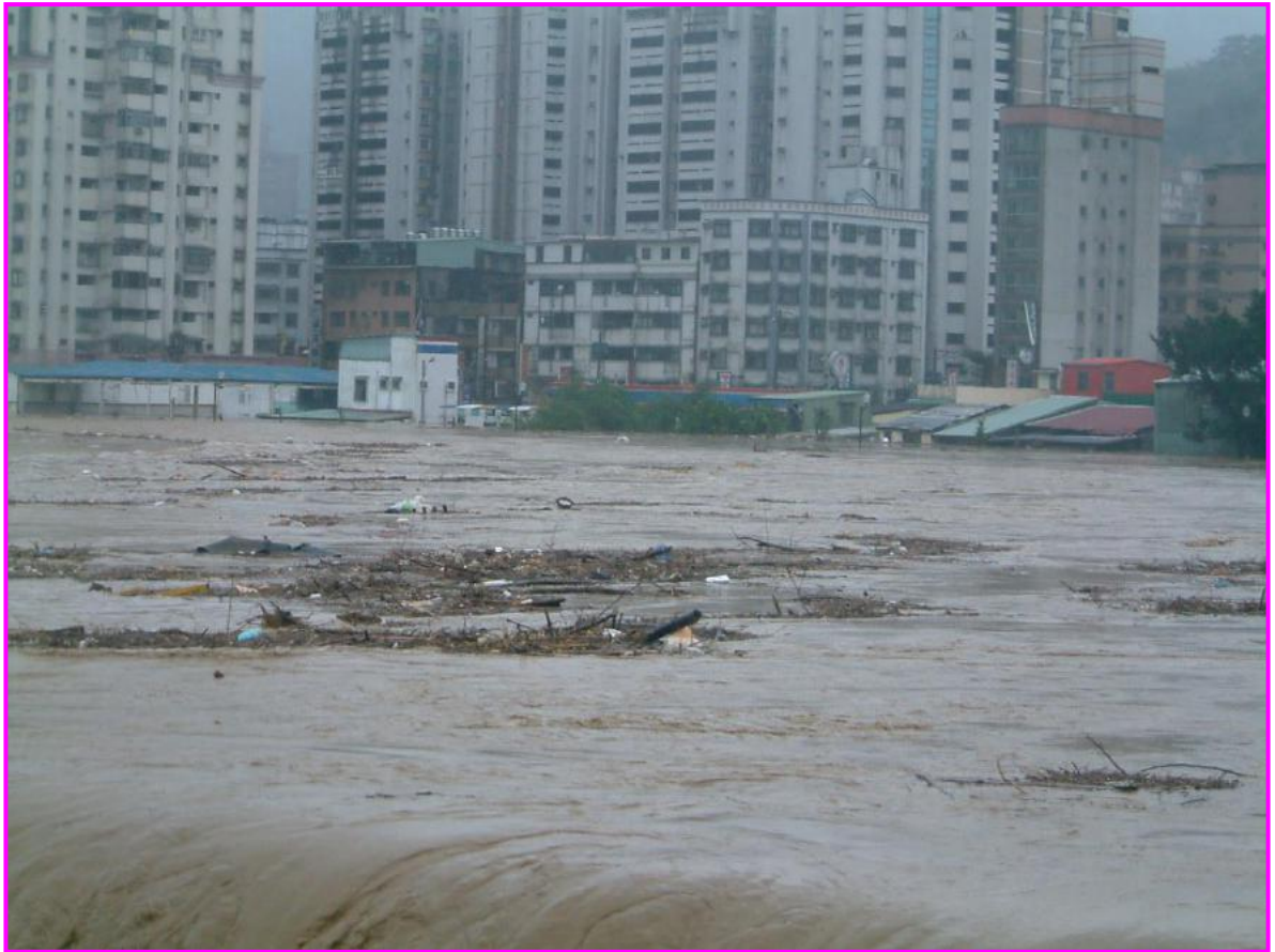
基隆河碇內堤防於 1025 納坦颱風洪水溢堤淹水情形
