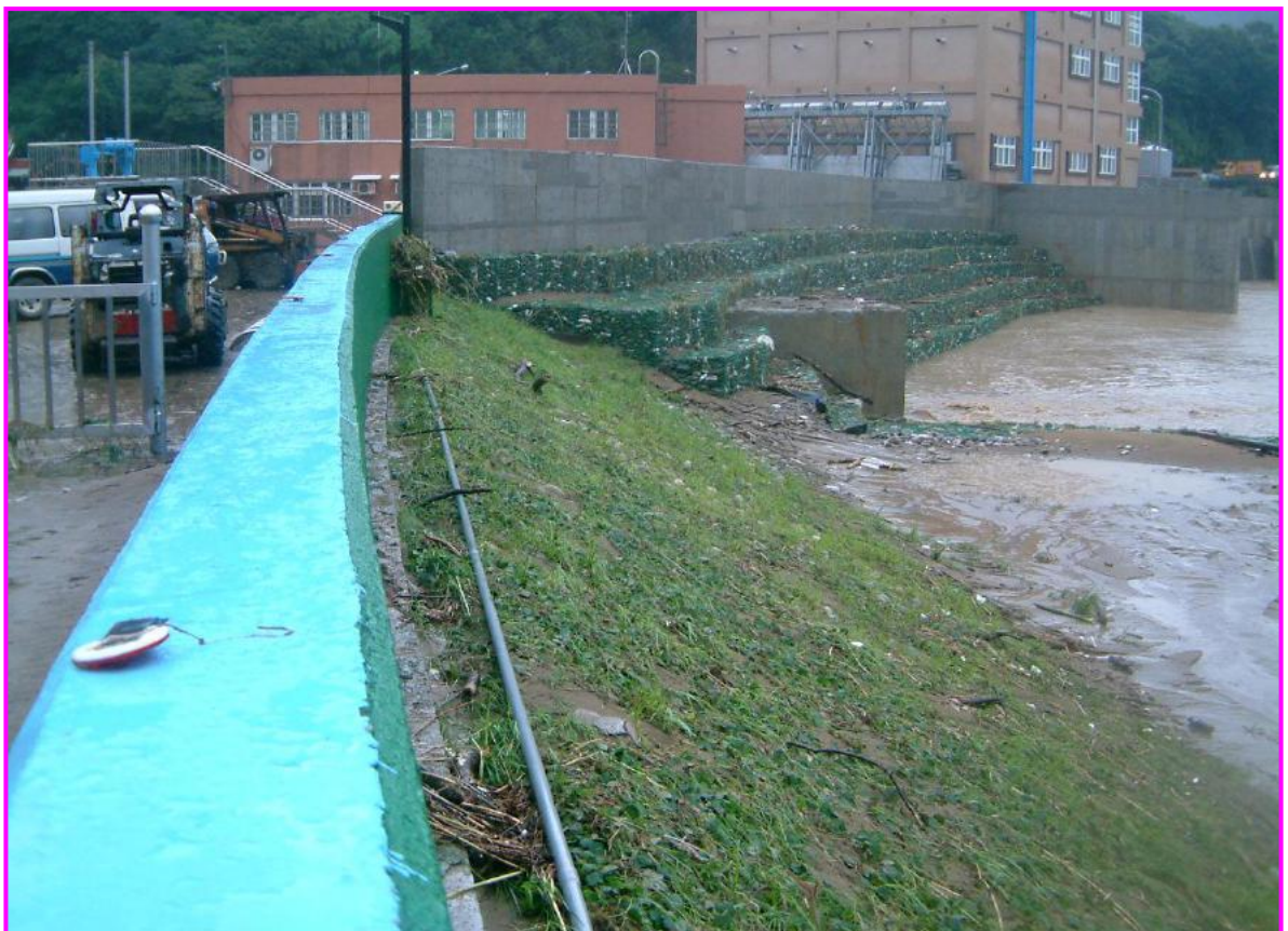
基隆河碇內堤防現況
